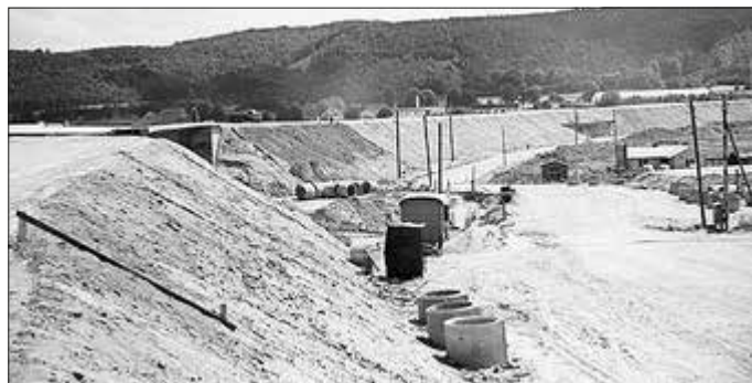
Bau der neuen Verbindungsstraße von Buchholz über die noch in Bau befindliche Autobahn BAB 38/A 6 im Jahr 1958
