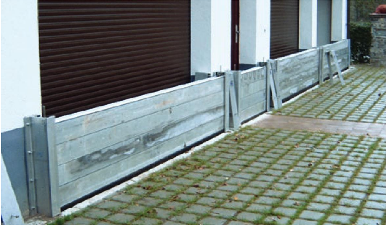
Abbildung: Mobiler Objektschutz vor Garageneinfahrten (Dammbalken)
