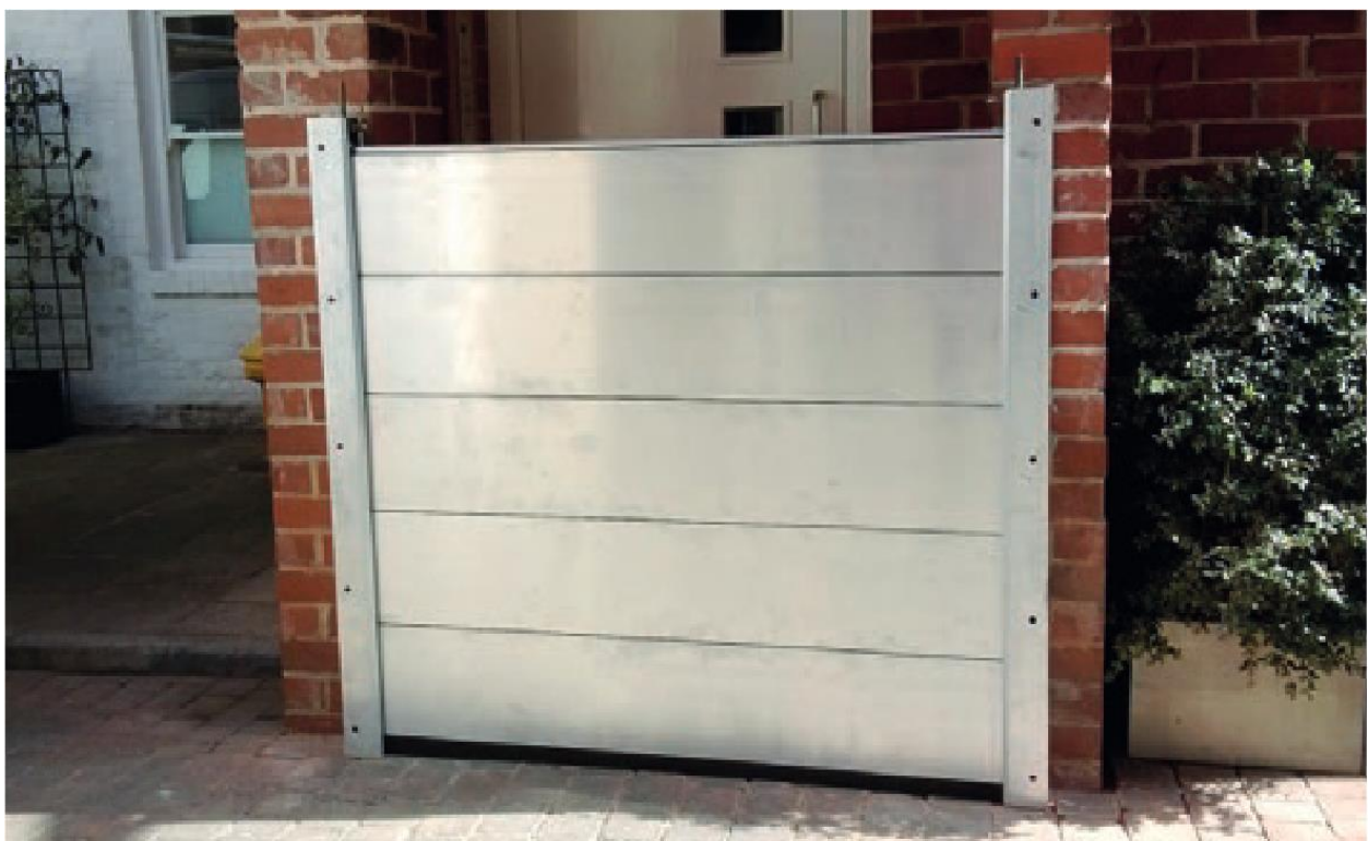
Abbildung: Mobiler Objektschutz vor Hauseingang (Dammbalken)
