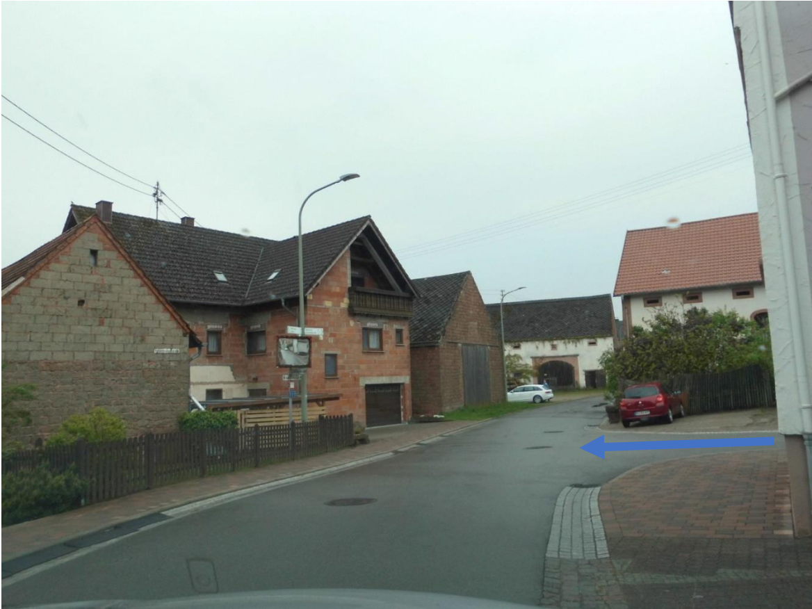
Abbildung: Blick in die Senke der Felsenbrunnerstraße / Schutz vor Oberflächenwasserzufluss
