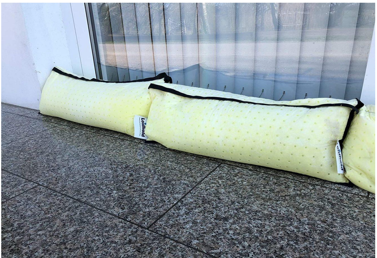
Abbildung: Wasserschutzkissen vor Eingangsbereich
