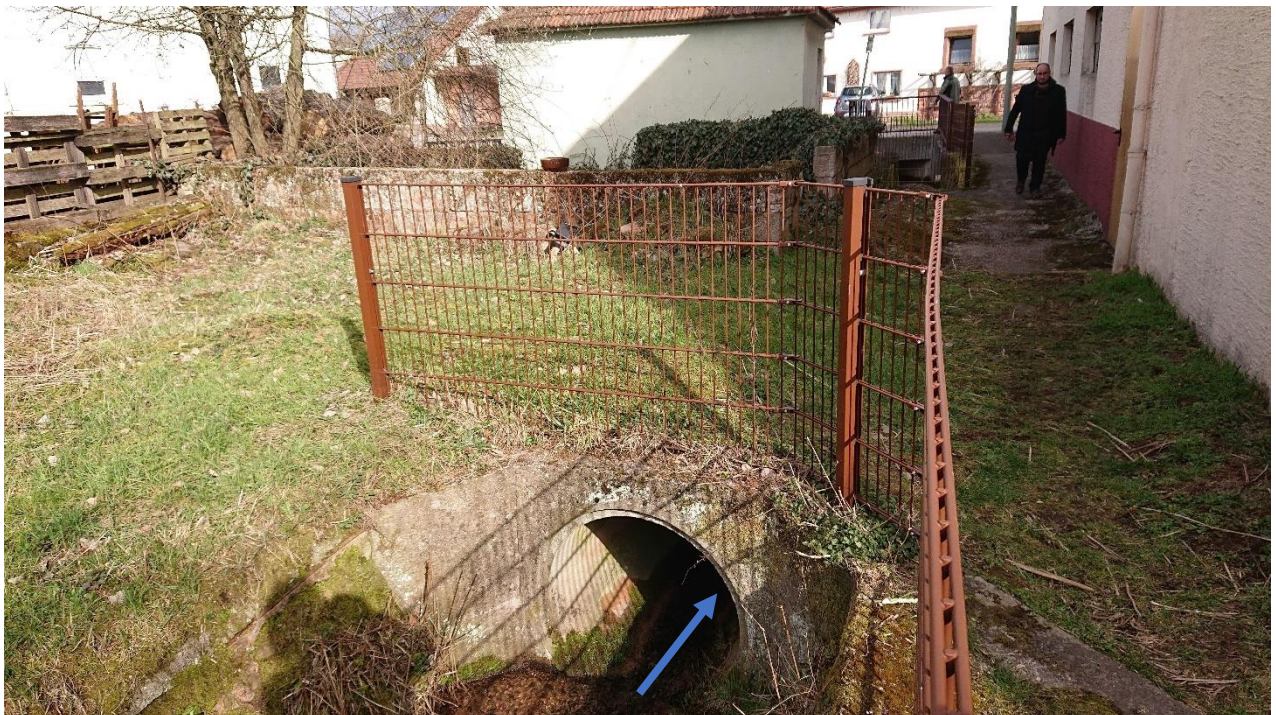
Abbildung: Woogbach, Rohrdurchlass (DN 800) im Bereich der Bebauung
