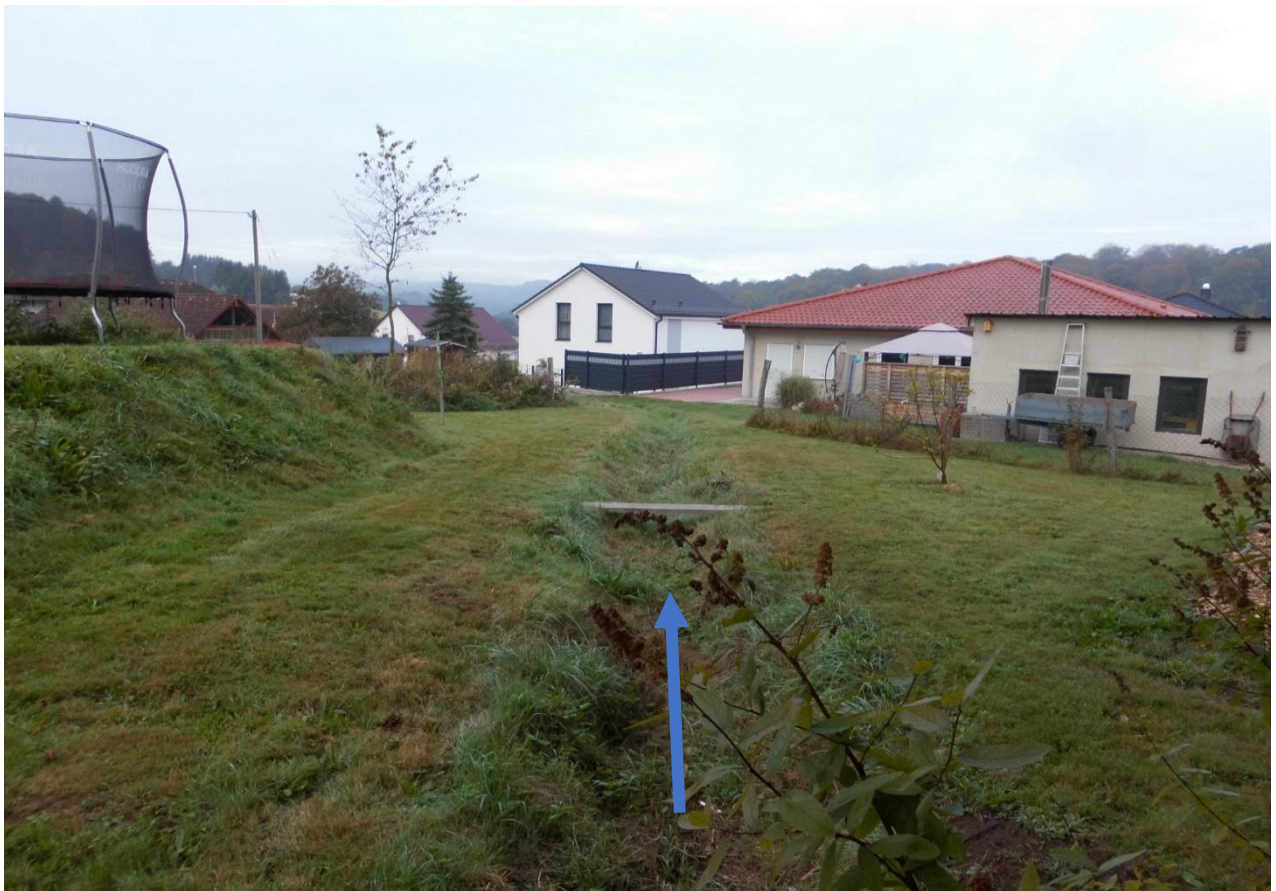
Abbildung: Sicherung der angrenzenden Grundstücke / Objektschutz und Nachprofilierung des Grabens
