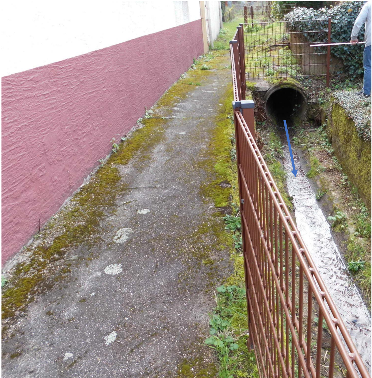
Abbildung: Woogbach, Auslauf DN 800 gegen Fließrichtung, befestigtes eingeeignetes Abflussprofil
