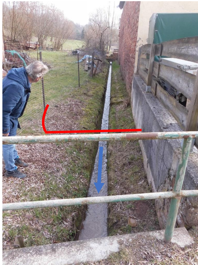
Abbildung: Kesselbach, oberhalb Überfahrt, überströmbarer Rechen einbauen
