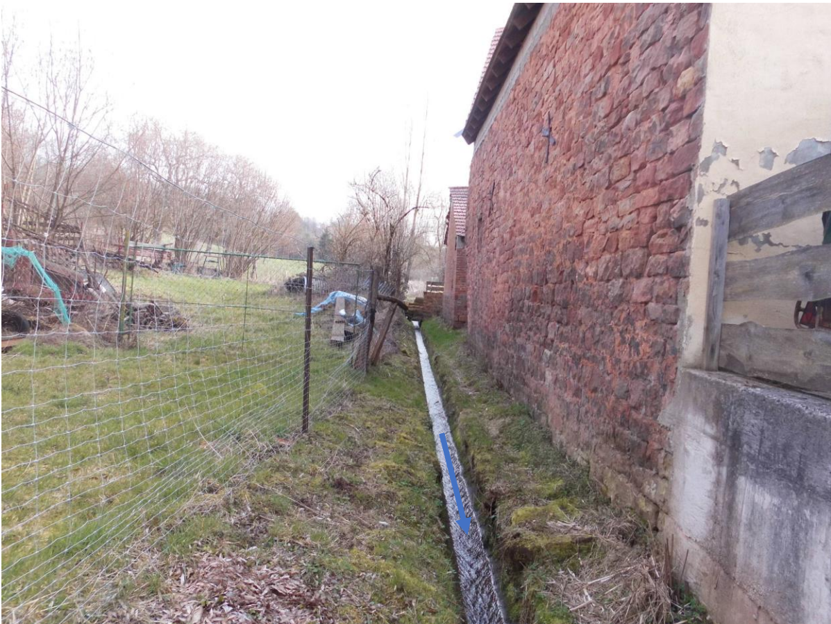
Abbildung: Kesselbach oberhalb der Eckstraße, befestigtes Gerinne (Halbschale)
