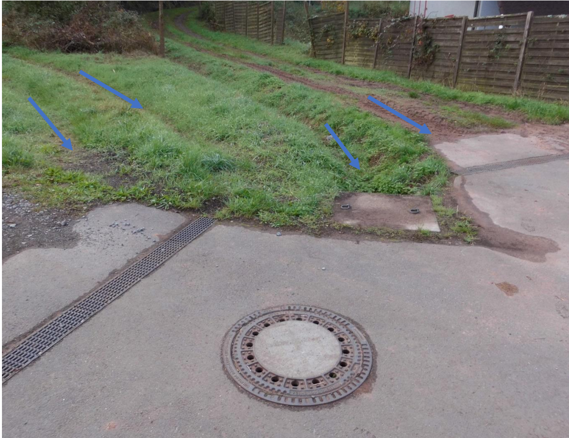
Abbildung: Einlaufbereich Martinshöherweg, Graben und wasserführender Weg
