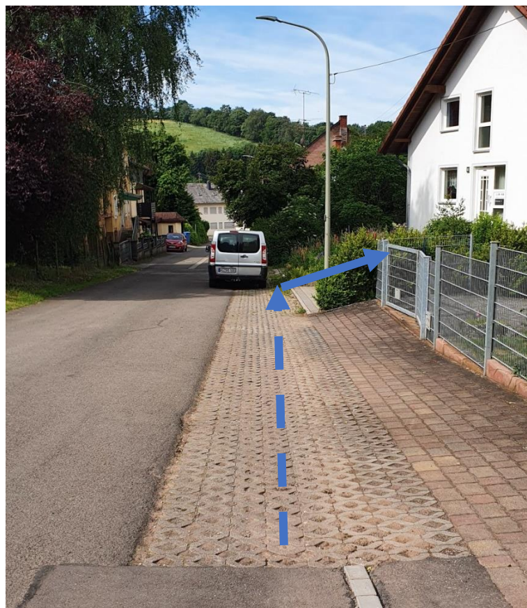
Abbildung: Eckstraße/ Prüfen der Entwässerungssituation
