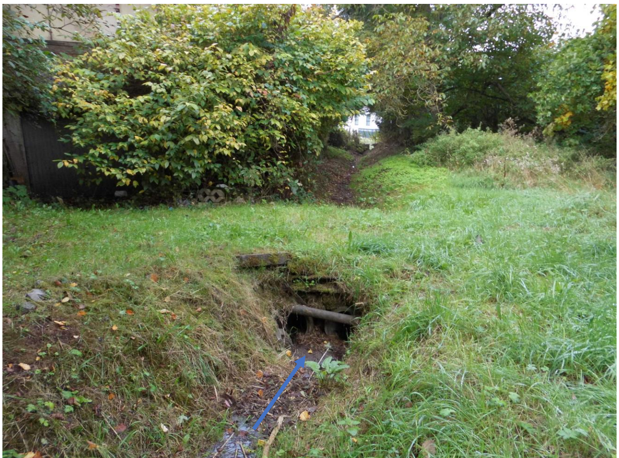
Abbildung: Behelfsüberfahrt mit 2x DN 300 unterhalb des Auslaufes
