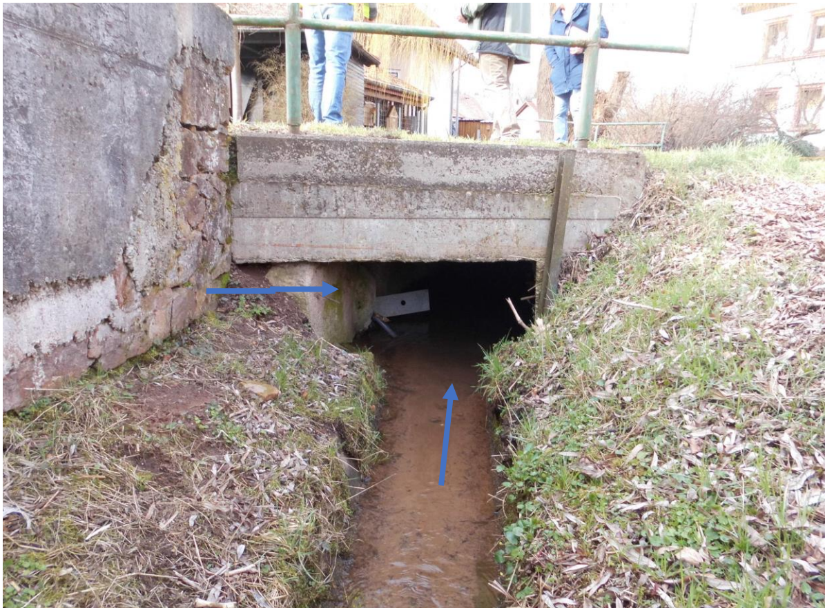
Abbildung: Kesselbach Überfahrt der Eckstraße; Profil am Einlauf, b/h = 1,10 / 0,70\text{m} ; linksseitige Einleitung der Straßenentwässerung
