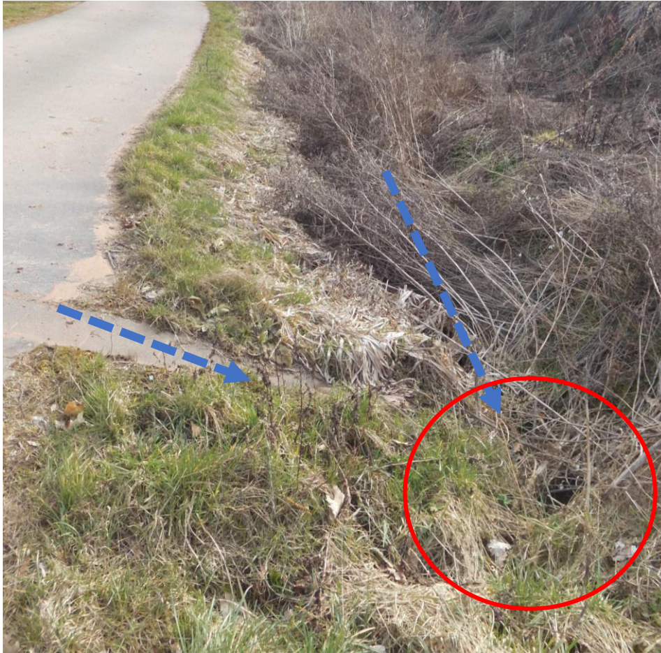
Abbildung: Wirtschaftsweg „Hauptstraße“ Einlaufbereich freilegen
