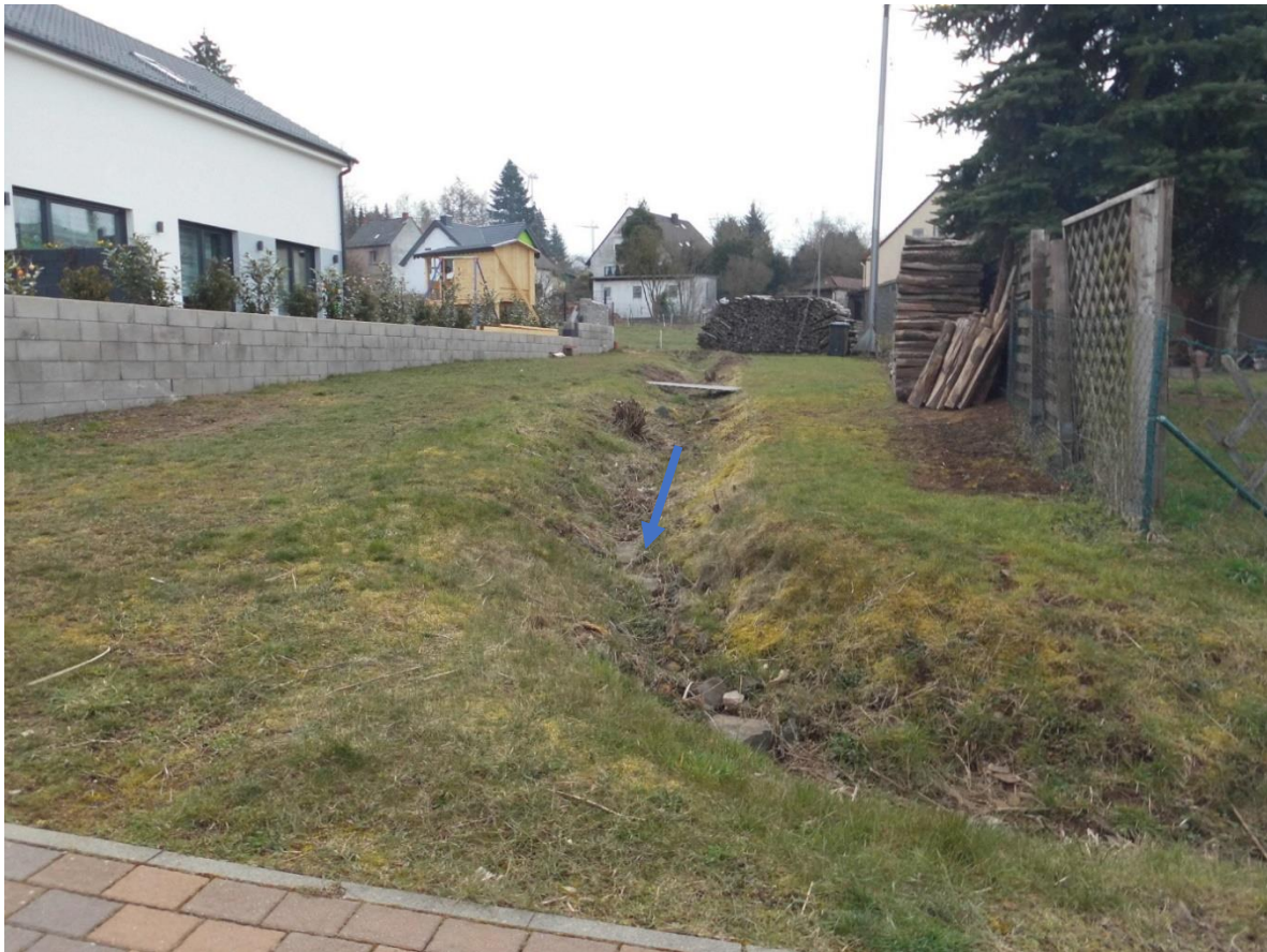
Abbildung: Offener Graben von Eckstraße zum Hauptstuhler Flur
