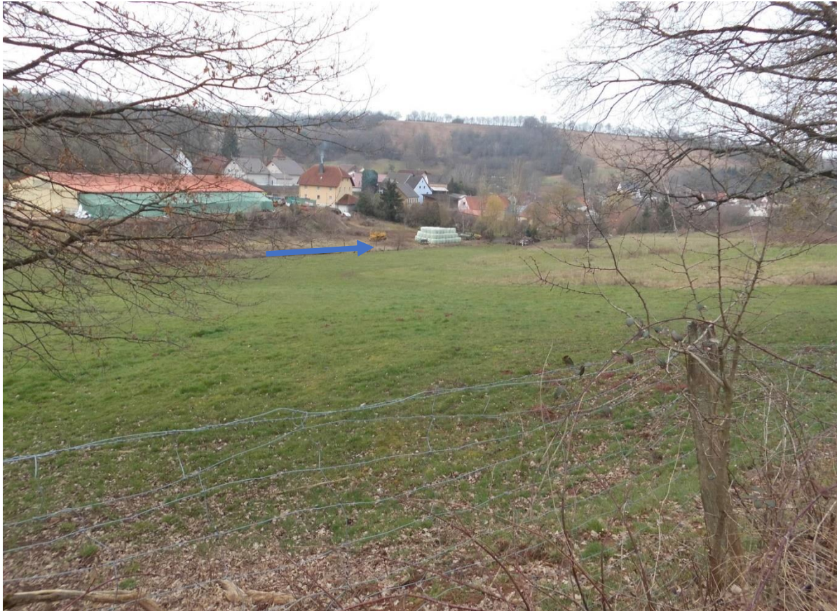
Abbildung: Blick aus Norden auf den Kesselbach
