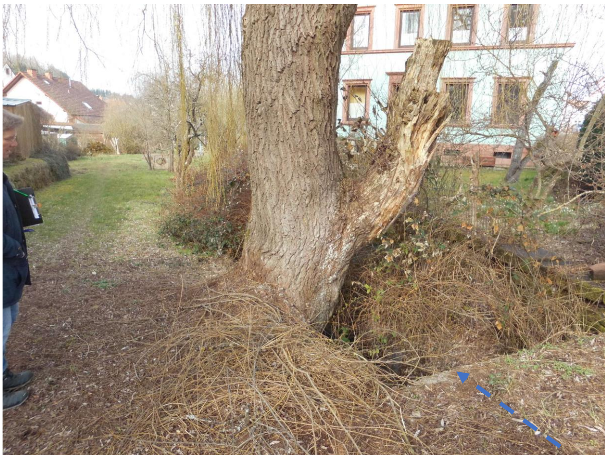
Abbildung: Kesselbach, unterhalb Überfahrt freilegen
