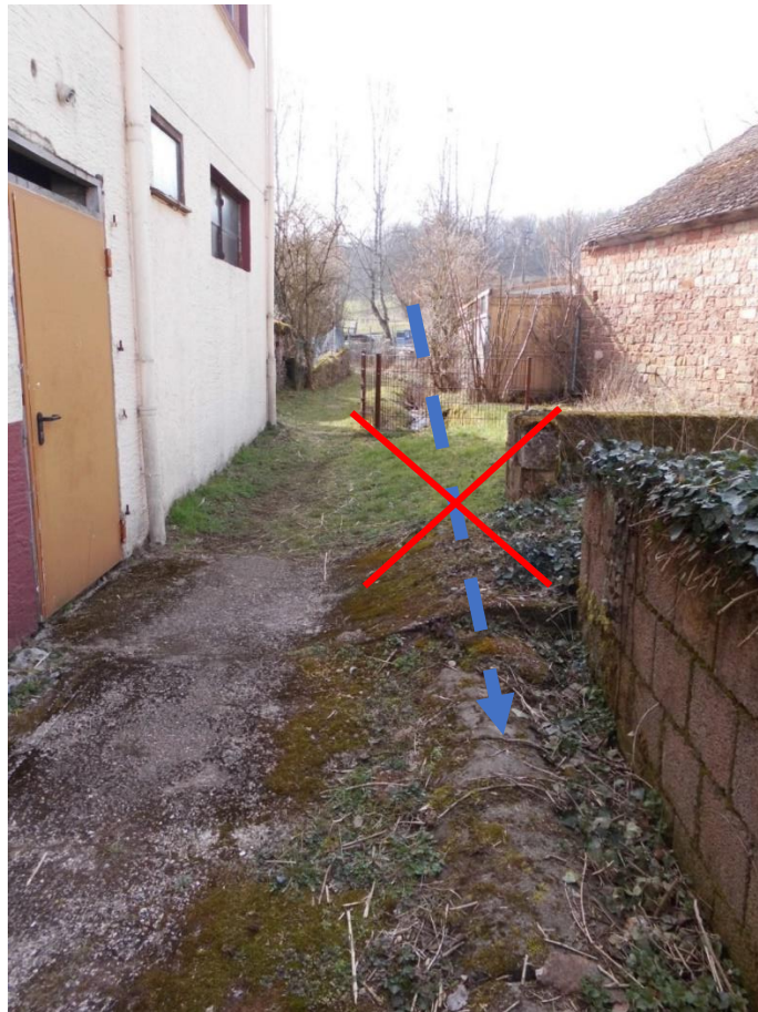
Abbildung: Verrohrung DN 800 zurückbauen
