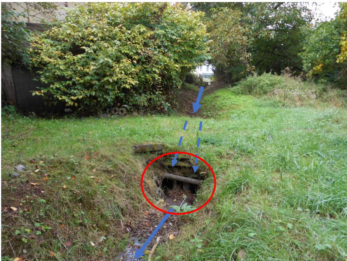
Abbildung: Grabensystem / Hindernisse im Graben beseitigen
