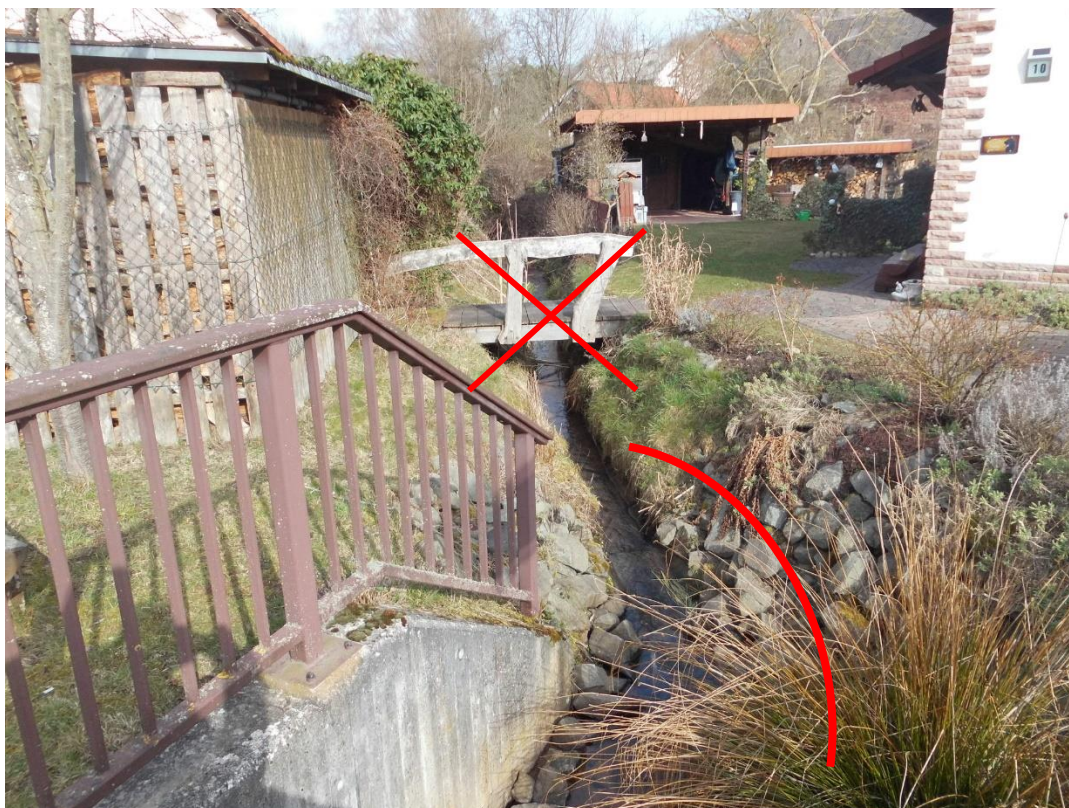
Abbildung: Optimierung Auslaufbereich / Engstelle verbreitern, Objektschutz durchführen
