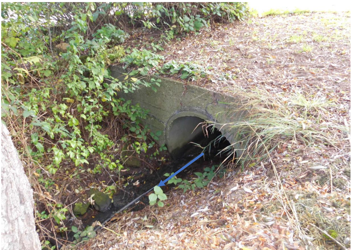
Abbildung: Kesselbach, Unterhalb der Eckstraße Auslauf (DN 1000)
