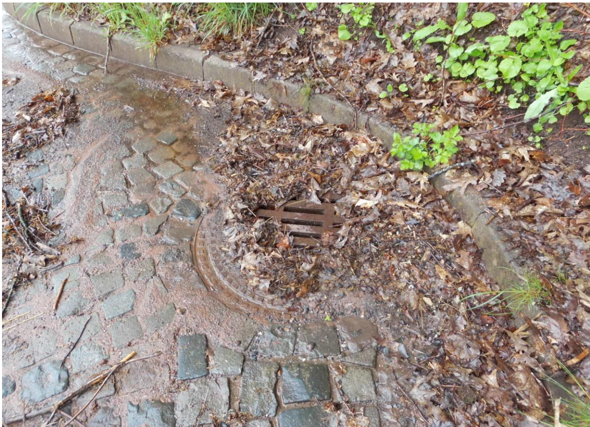
Abbildung: Bergeinlauf K 68 Unterhaltungsmaßnahmen
