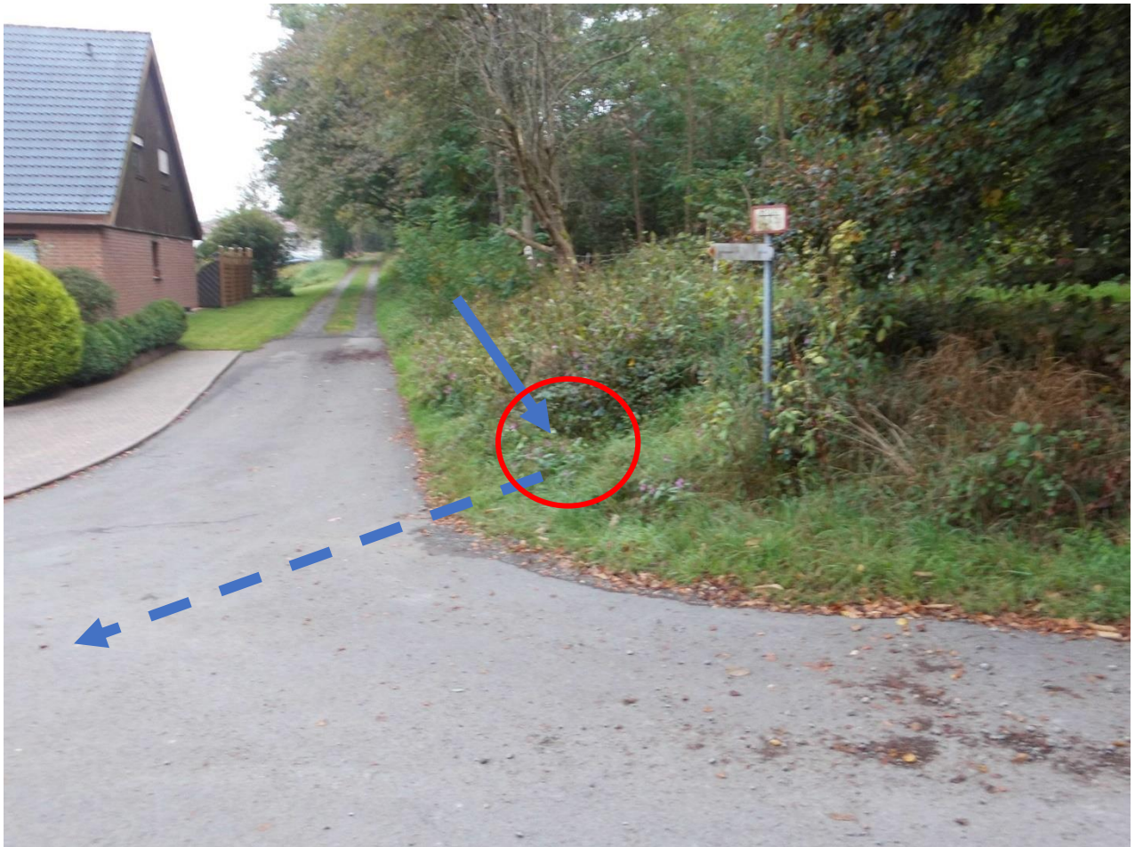
Abbildung: Einlaufbereich freischneiden, freilegen
