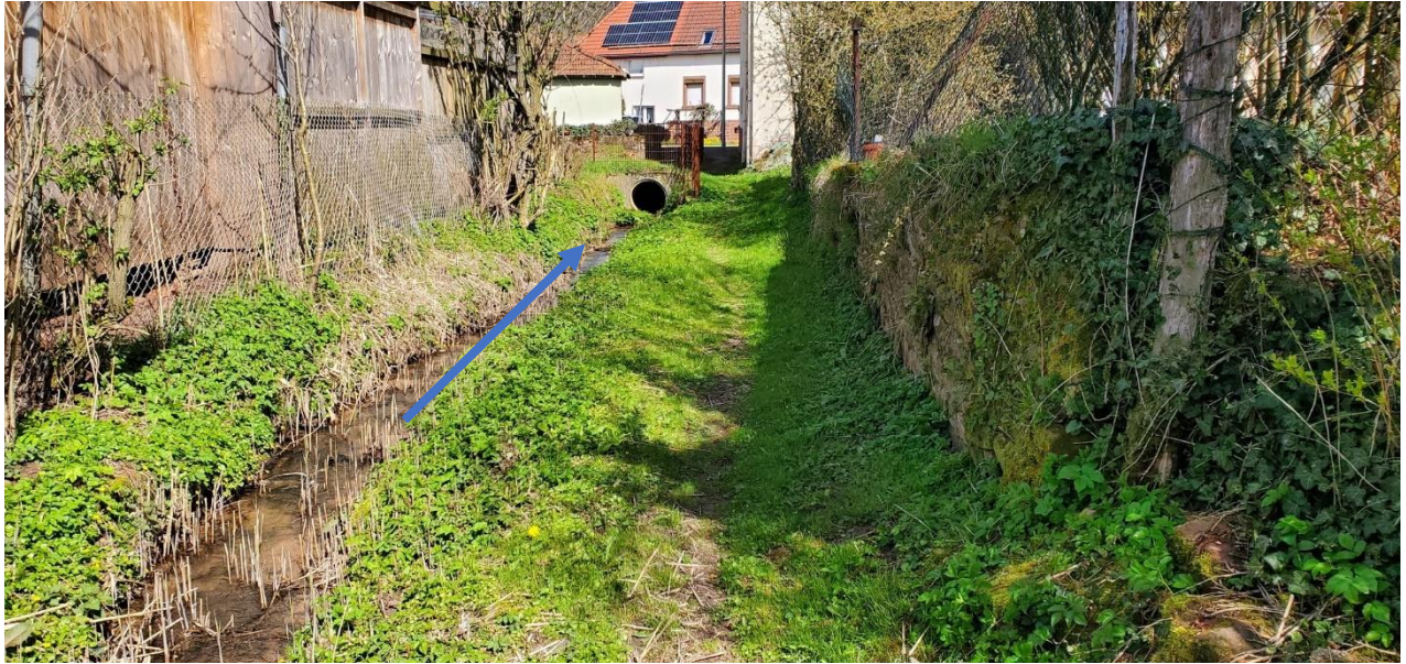
Abbildung: Woogbach, vor dem Rohrdurchlass (DN 800)
