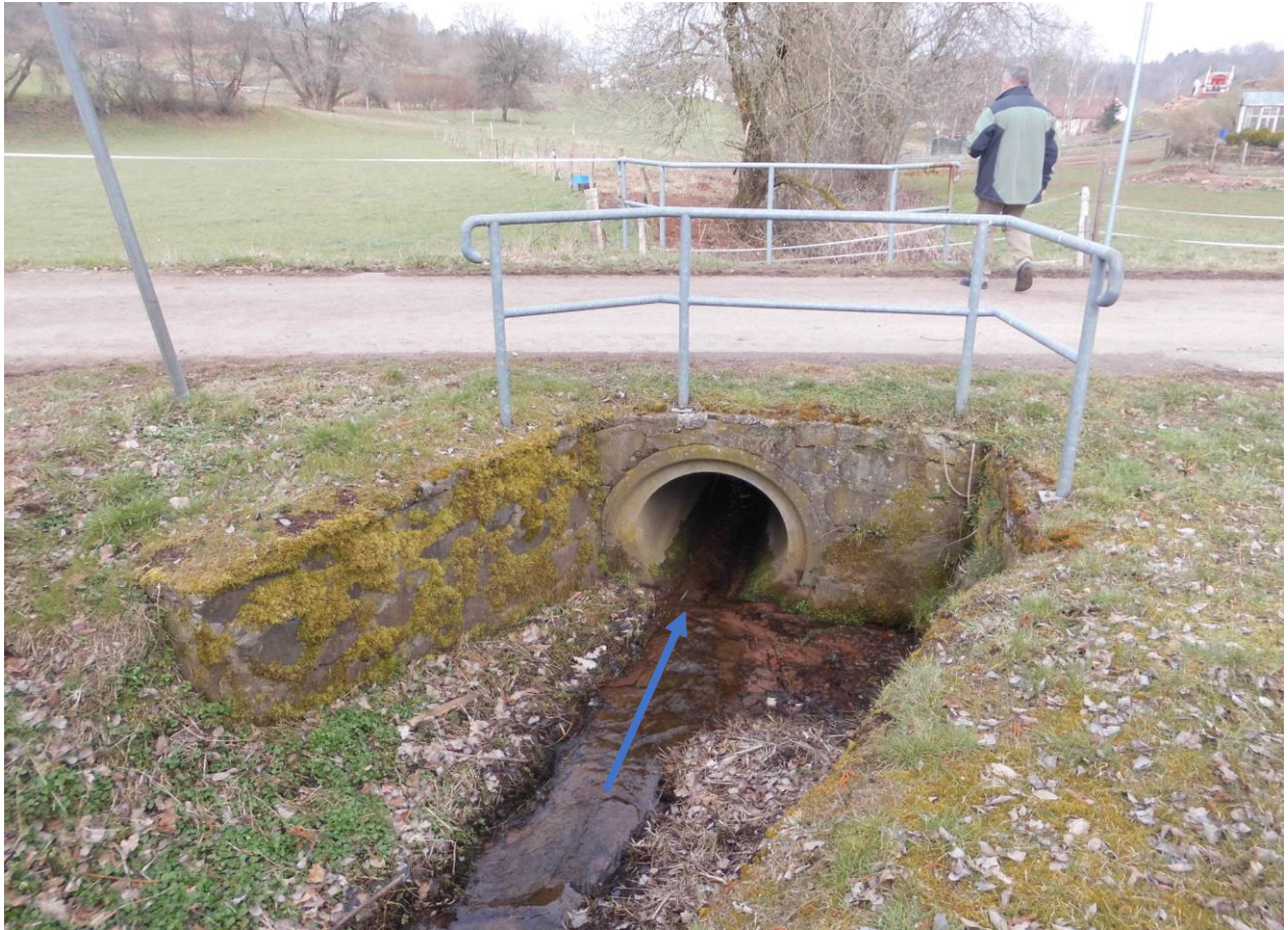
Abbildung: Woogbach, Überfahrt (DN 800), südöstlicher Wirtschaftsweg
