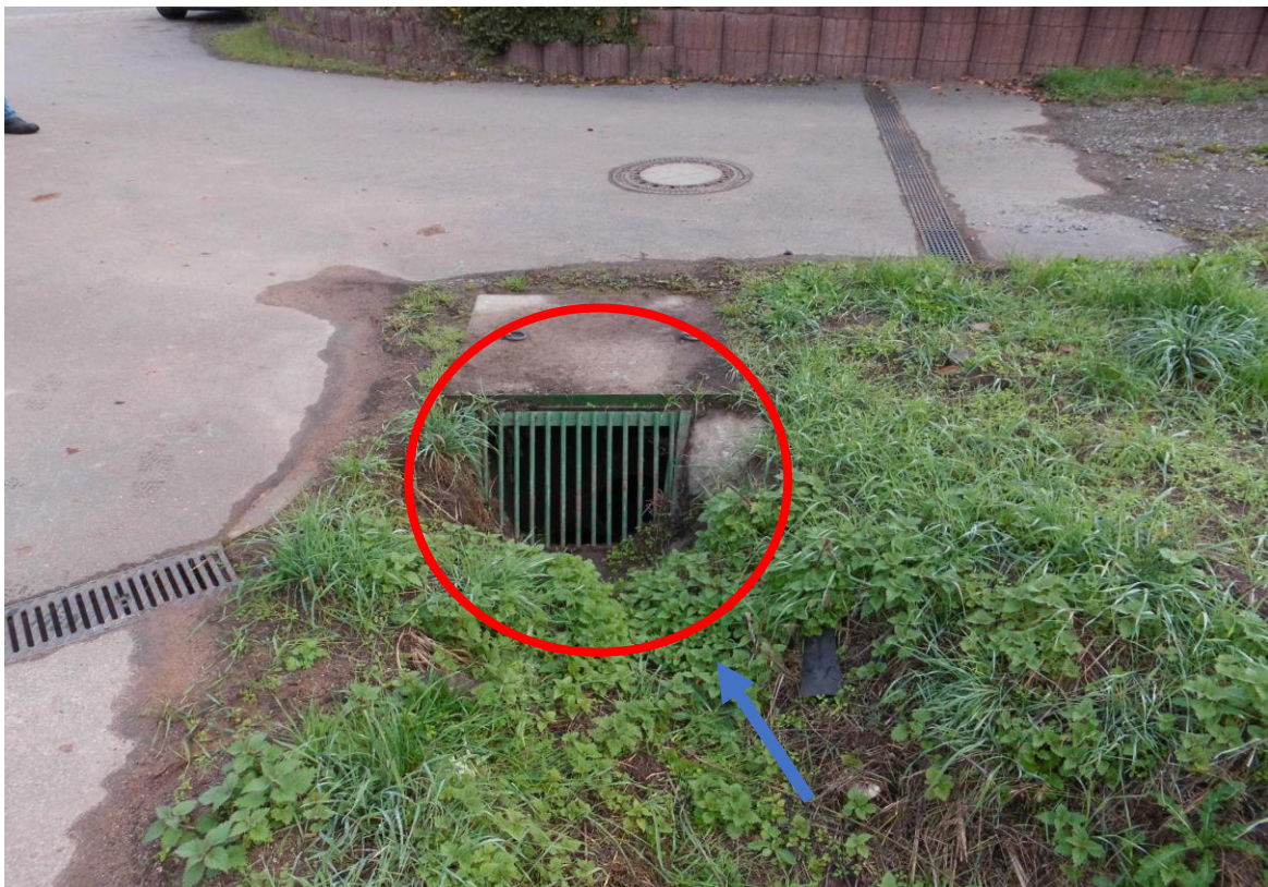
Abbildung: Einlaufbereich Martinshöherweg/ Einlaufgitter
