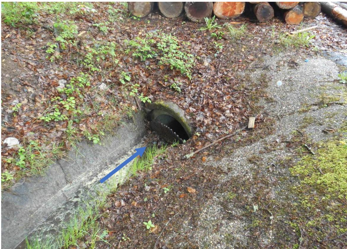
**Abbildung: Rohreinlauf mit provisorischem Gitter / Herstellung eines Einlaufbauwerkes
