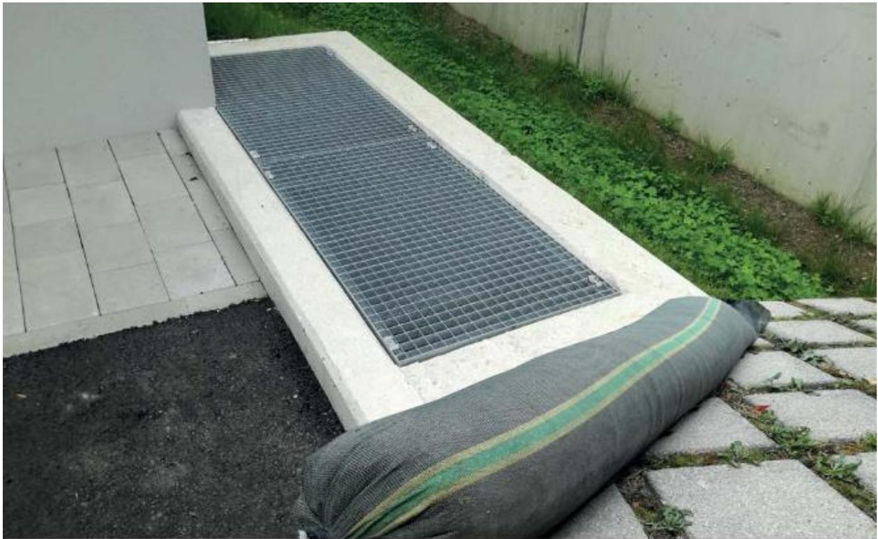
**Abbildung: Kellerfenster mit erhöhtem Lichtschacht zusätzlich durch Sandsack vor Wassereintritt geschützt**
