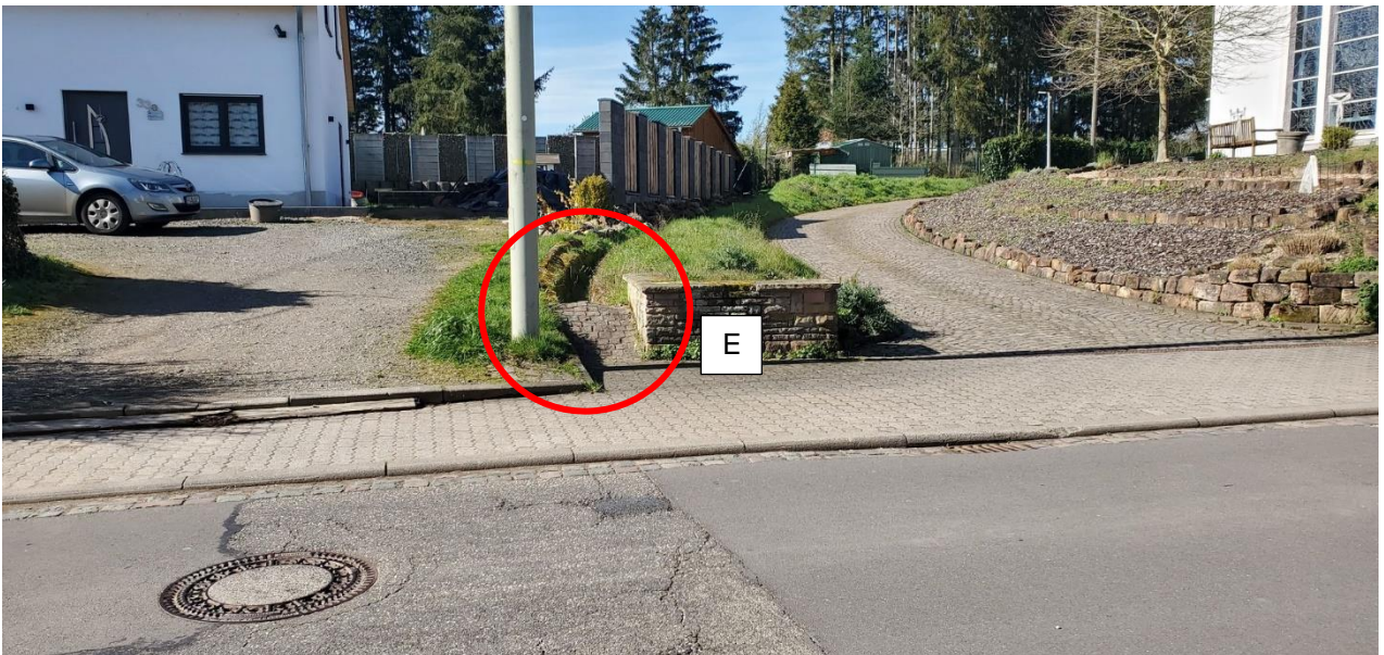
Abbildung: Vorh. Einlaufbereich an der Nikolauskirche
