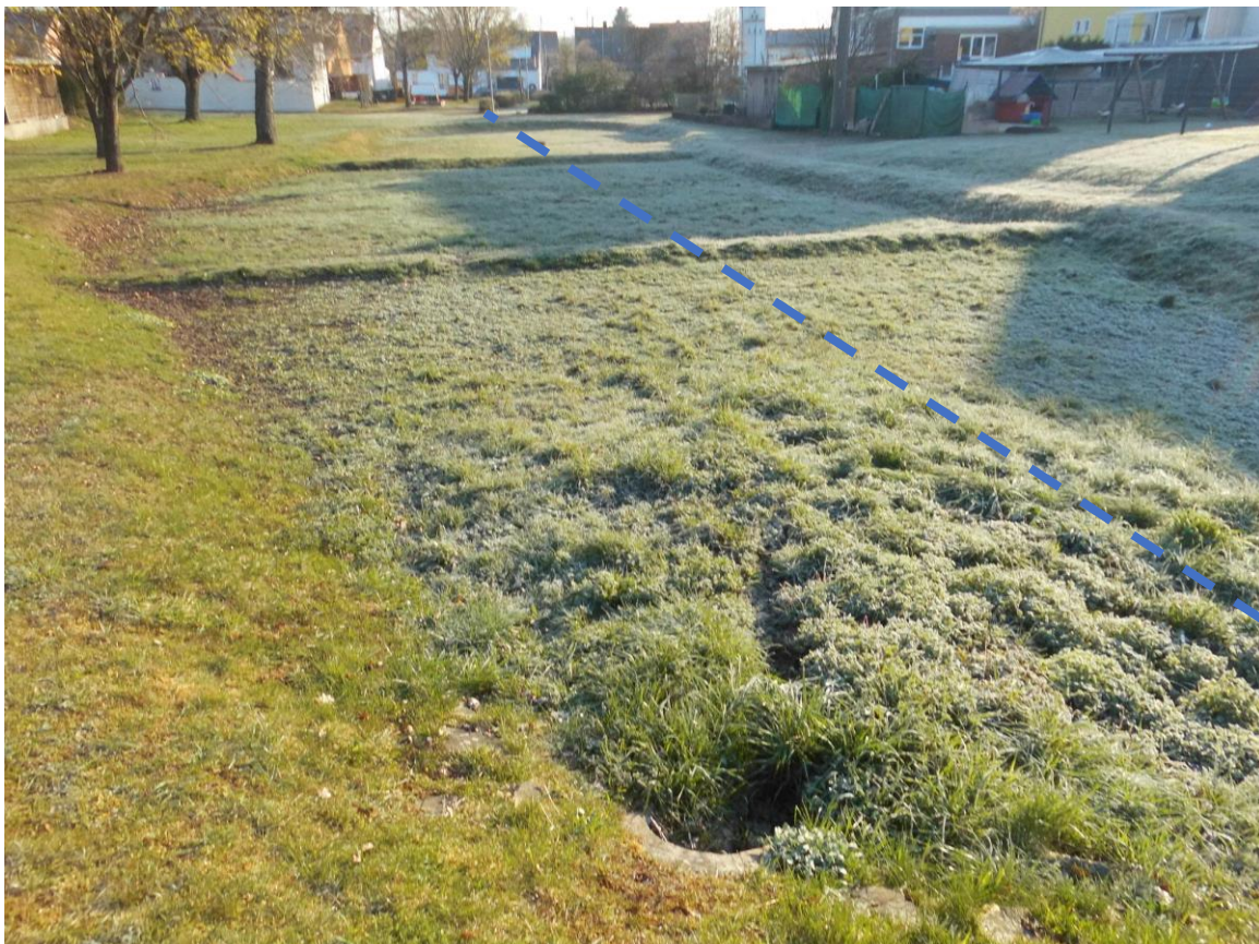
Abbildung: Rückhaltemaßnahme „Im Weiher“ mit Verrohrung
