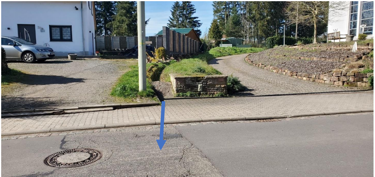
Abbildung: Graben zwischen Nikolauskirche und Nachbargrundstück
