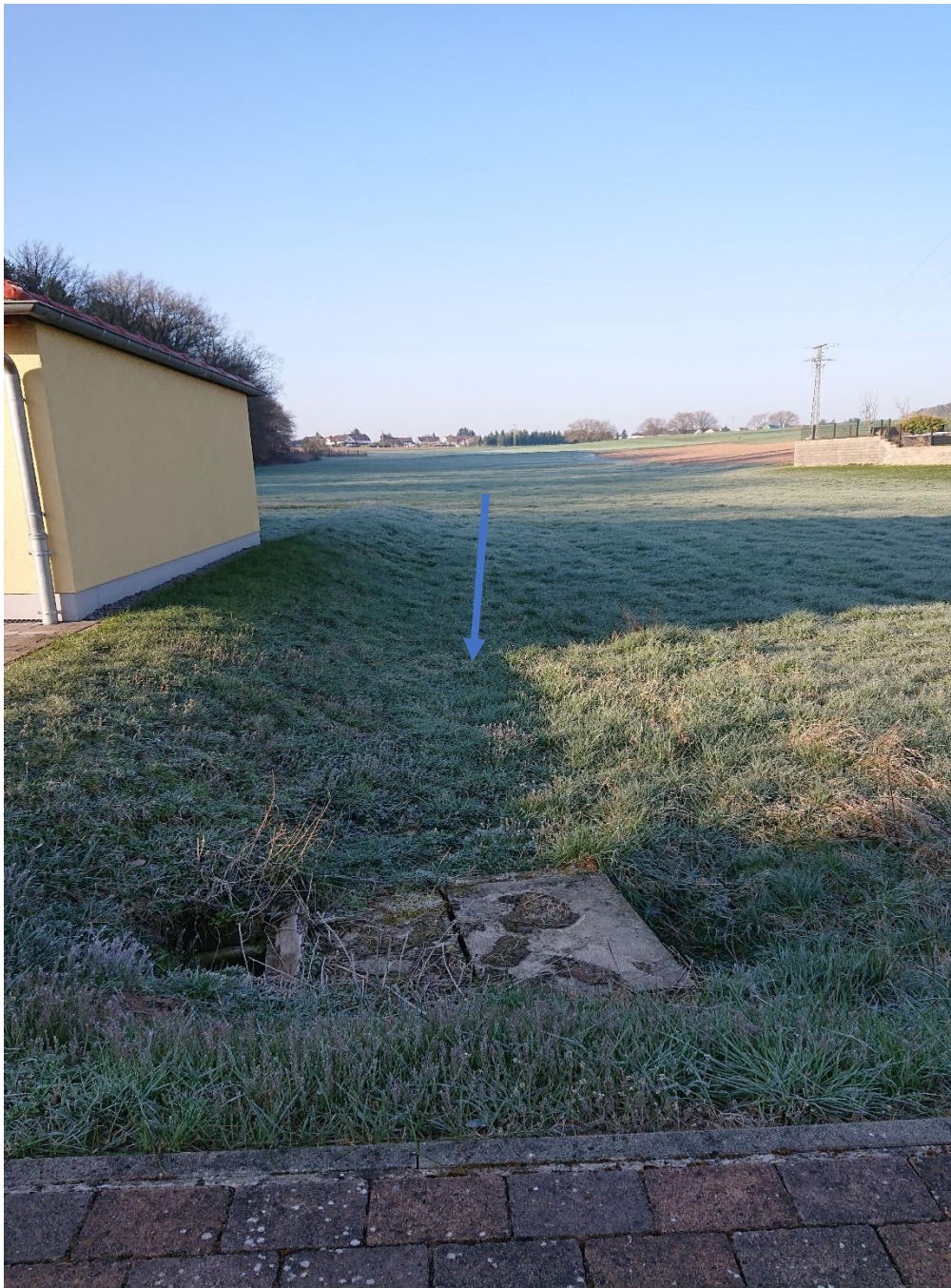
Abbildung: Einzugsgebiet „Im Weiher“ / Einlaufbauwerk
