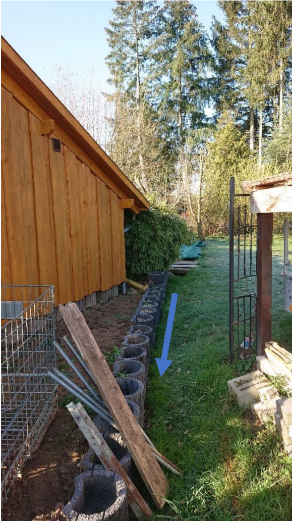
Abbildung: Wasserführung oberhalb Bebauung
