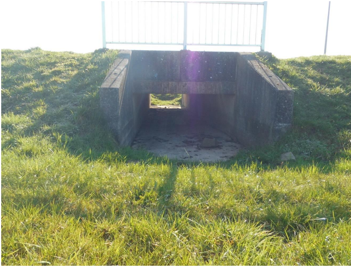
Abbildung: Durchlassbauwerk im Damm der Mühlstraße
