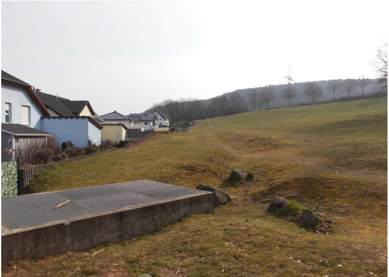
Abbildung: Einlaufbauwerk Tannenfeld, Grabensystem zum Schutz der Bebauung
