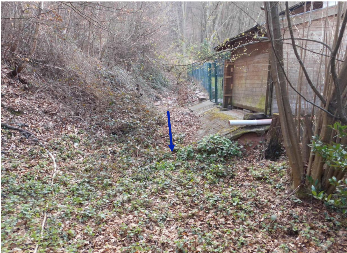
Abbildung: Seitengraben parallel zur Bebauung - gegen Fließrichtung
