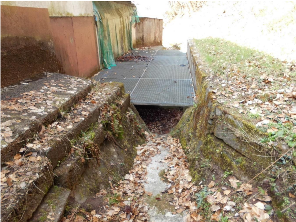
Abbildung: Einlaufbauwerk mit Verrohrung
