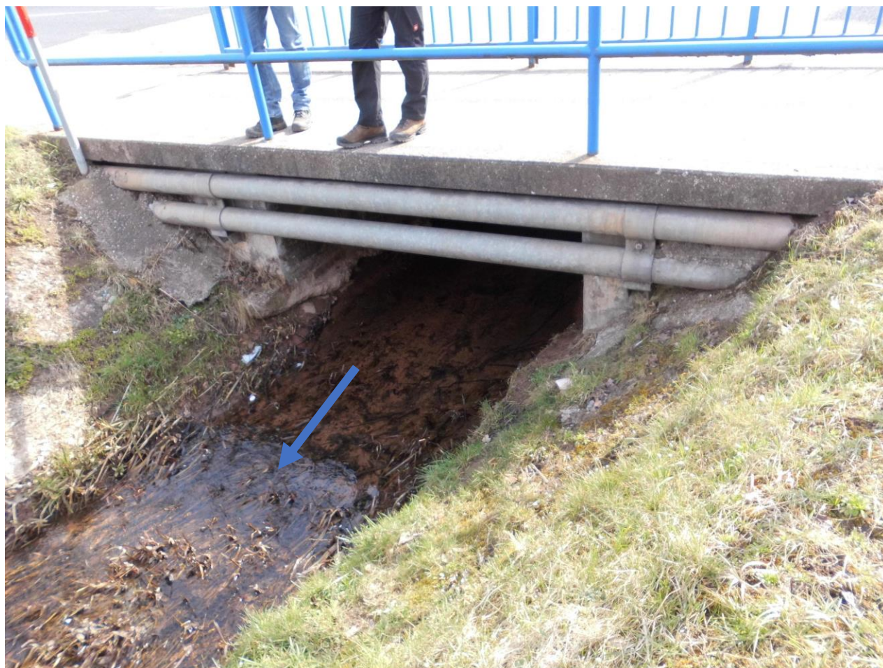
Abbildung: Versorgungsleitungen im Abflussquerschnitt
