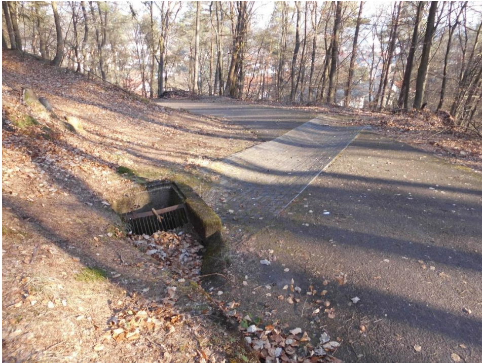
Abbildung: Bestehende Querrinne mit Einlaufbauwerk im Rotherweg
