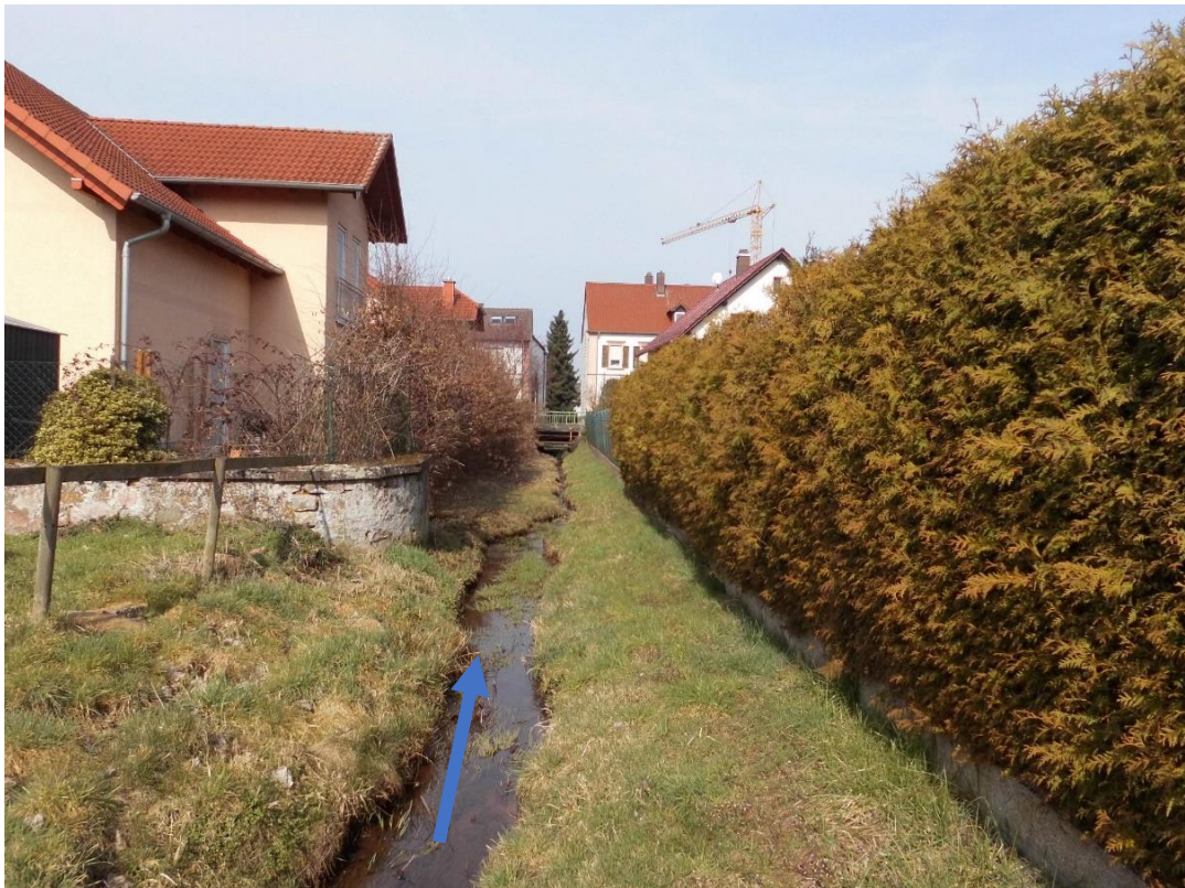
Abbildung: Einengung des Frohnbachs/ Treibgutrückhalt zum Schutz der Engstellen
