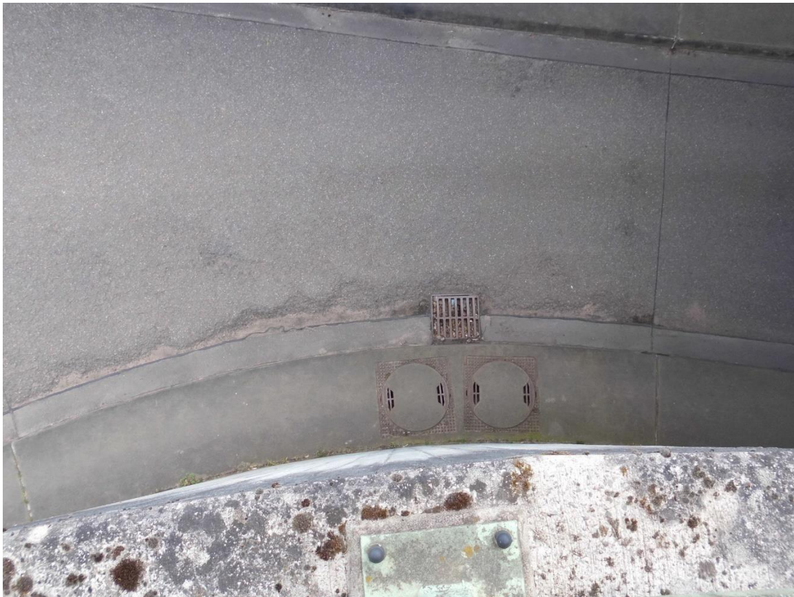
Abbildung: Einlaufschächte der Pumpstation
