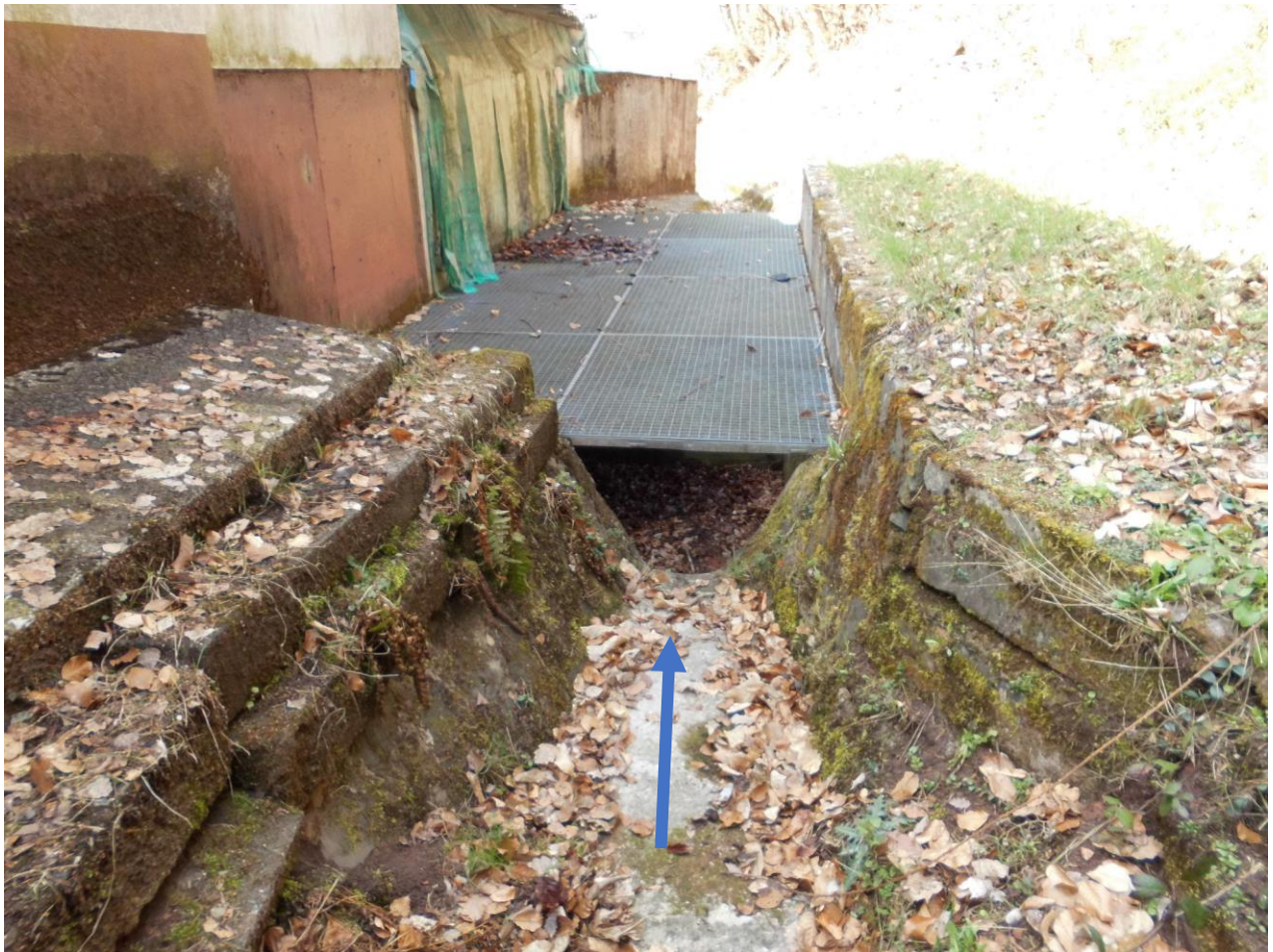
Abbildung: Einlaufbauwerk im Bereich der Belzmühle
