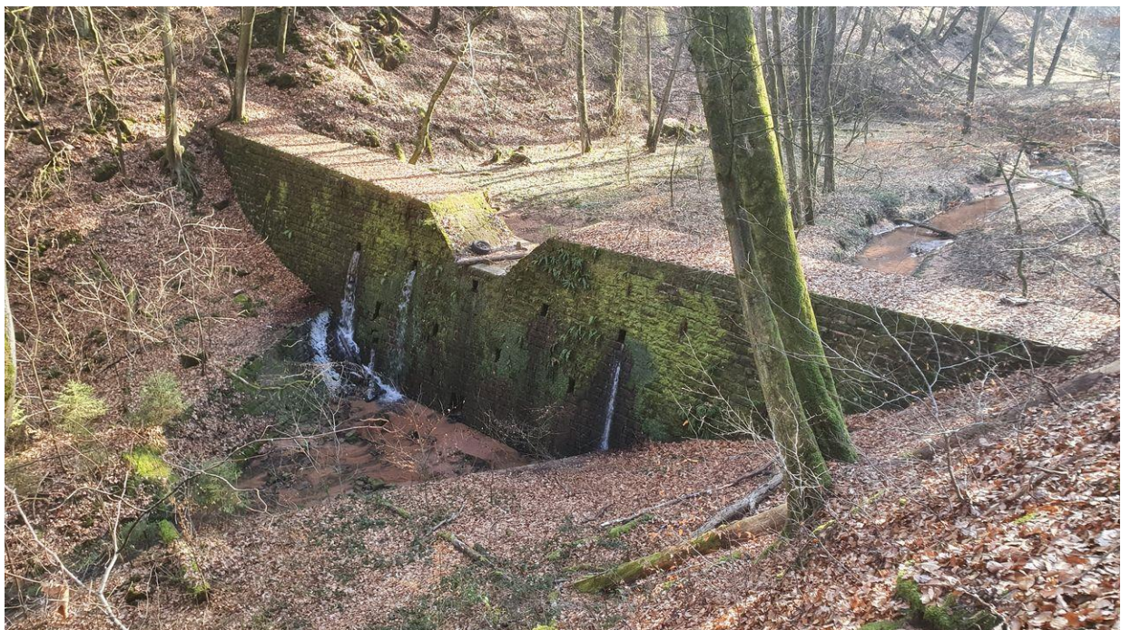
Abbildung: Staumauer im Mühlbach, Geröllrückhalt seit 1937
