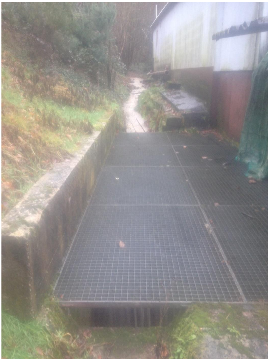
Abbildung: Einlaufbauwerk an der Belzmühle vom 09.02.2016
