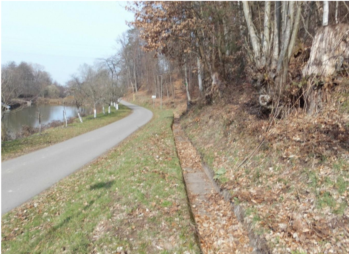
Abbildung: Gerinne Notüberlauf (Halbschalen)
