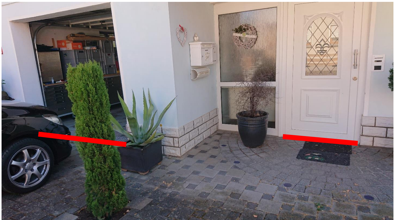
Abbildung: Zugänge zu „Am Herrenacker 1“ / Weitere Objektschutzmaßnahmen empfohlen!
