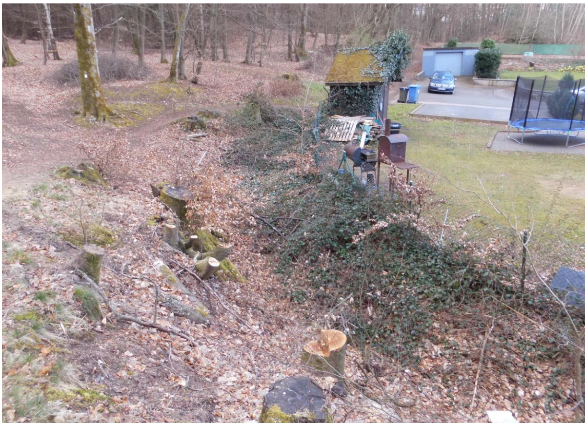
Abbildung: Abfanggraben vor der Bebauung
