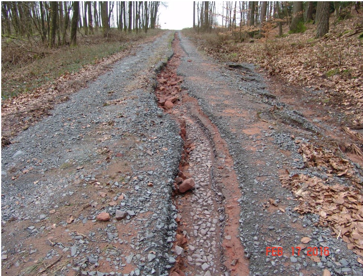
Abbildung: Ausspülungen des Wirtschaftsweges nach einem Starkregenereignis
