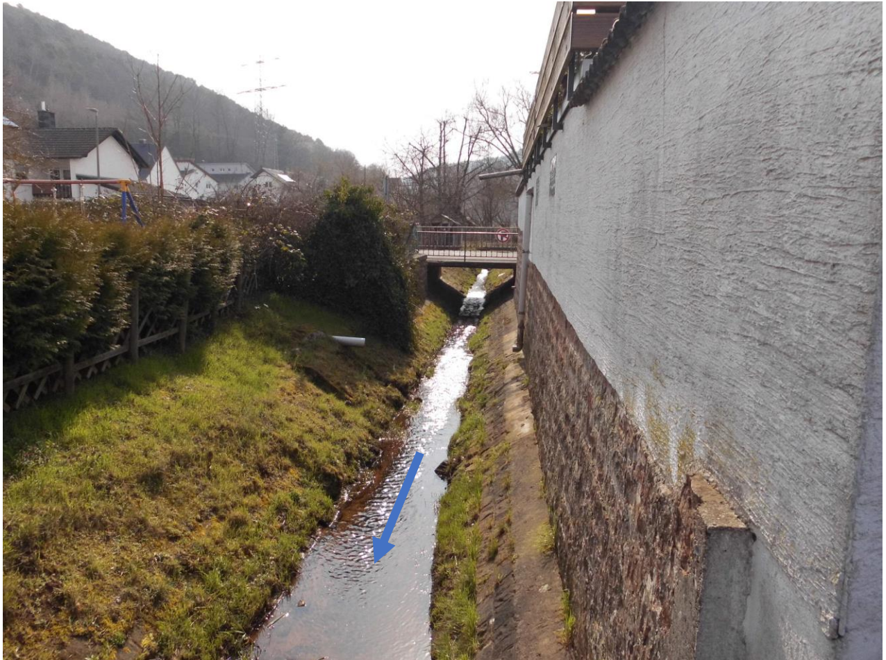
Abbildung: Engstelle des Mühlbaches gegen Fließrichtung in der Bebauung
