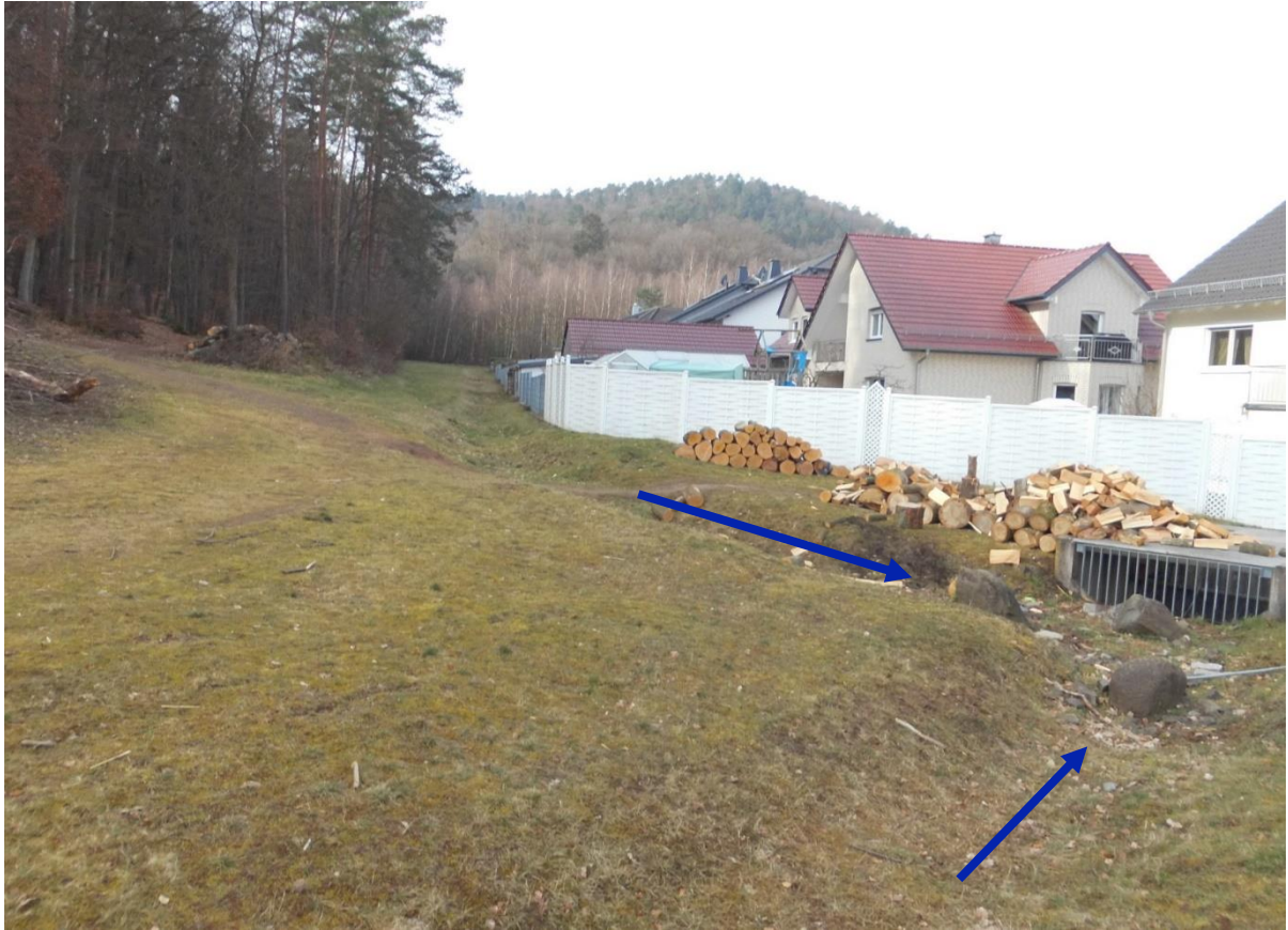
Abbildung: Westliches Einlaufbauwerk - Blick nach Westen
