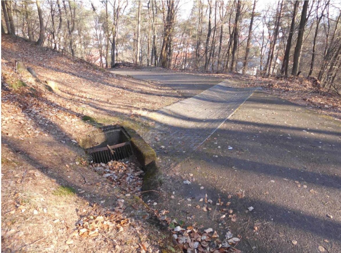
Abbildung: Querrinne mit Seitlichem Straßeneinlauf (belegt)
