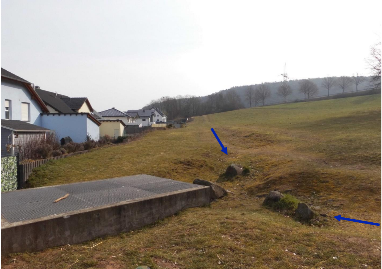
Abbildung: Östliches Einlaufbauwerk - Blick nach Osten
