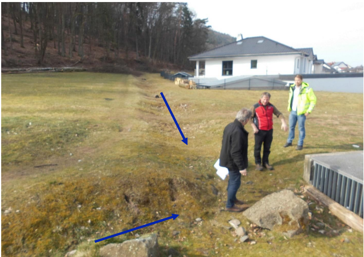
Abbildung: Östliches Einlaufbauwerk - Blick nach Südwesten
