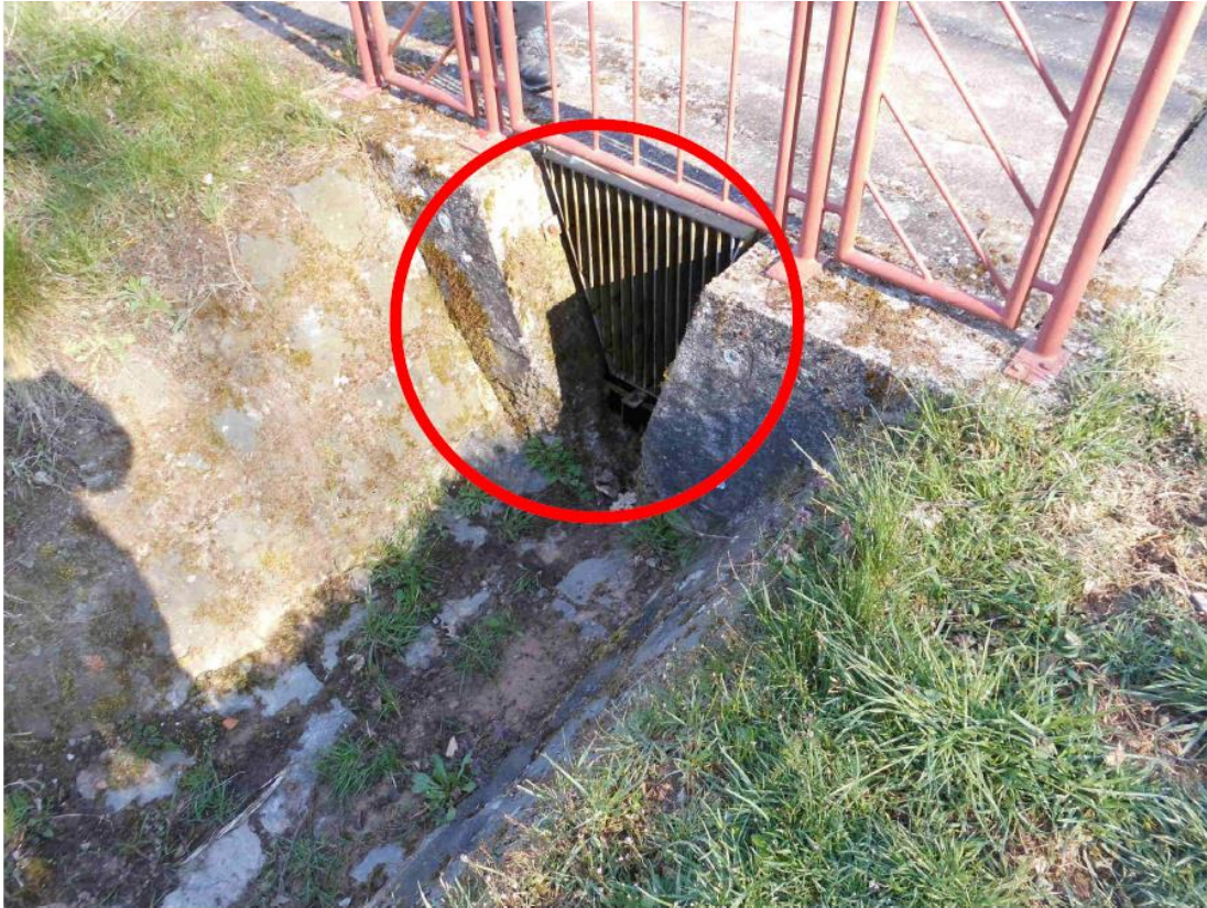
Abbildung: Bestehendes Einlaufbauwerk Hohlstraße
