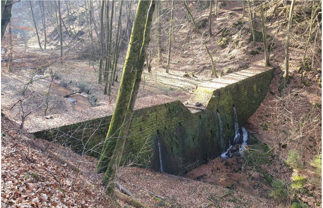
Abbildung: Staumauer (v. 1937) oberhalb der Belzmühle
