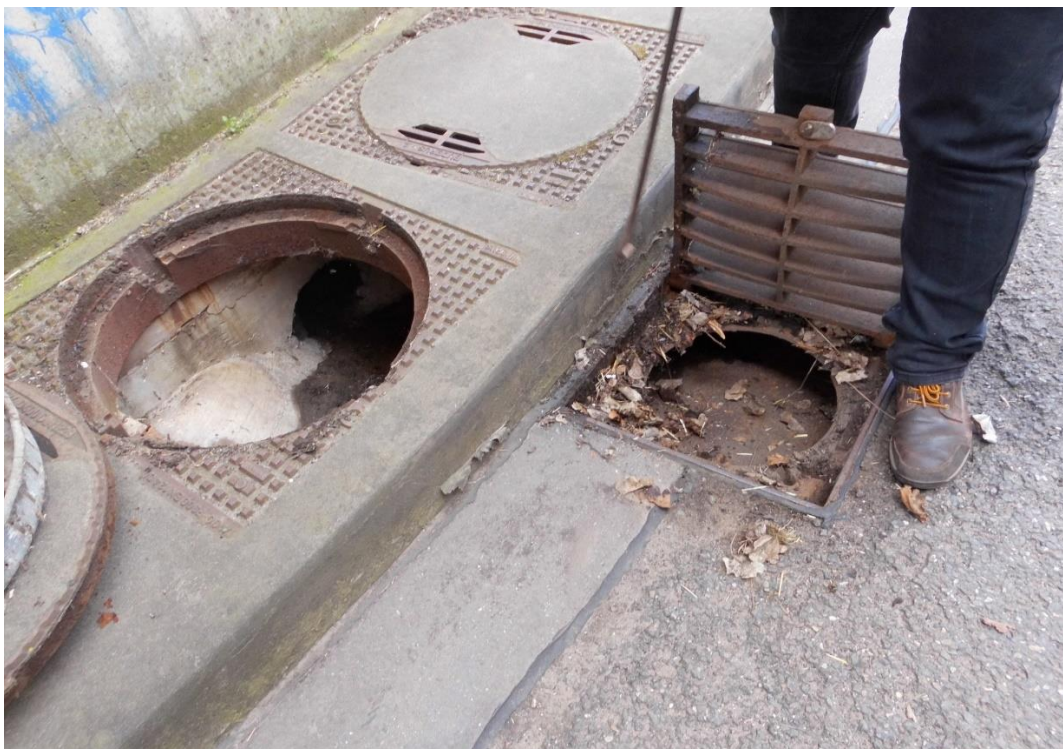
Abbildung: Einlaufschächte der Pumpstation
