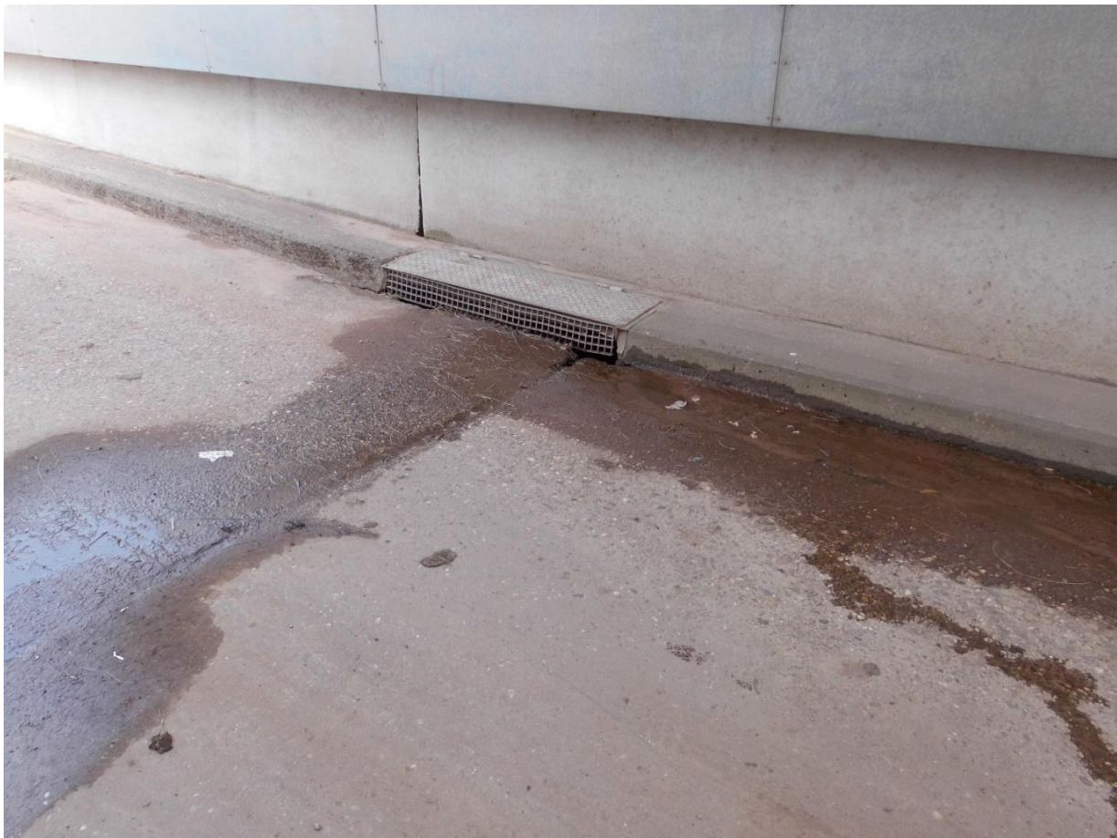
Abbildung: Ungeeigneter Einlauf
