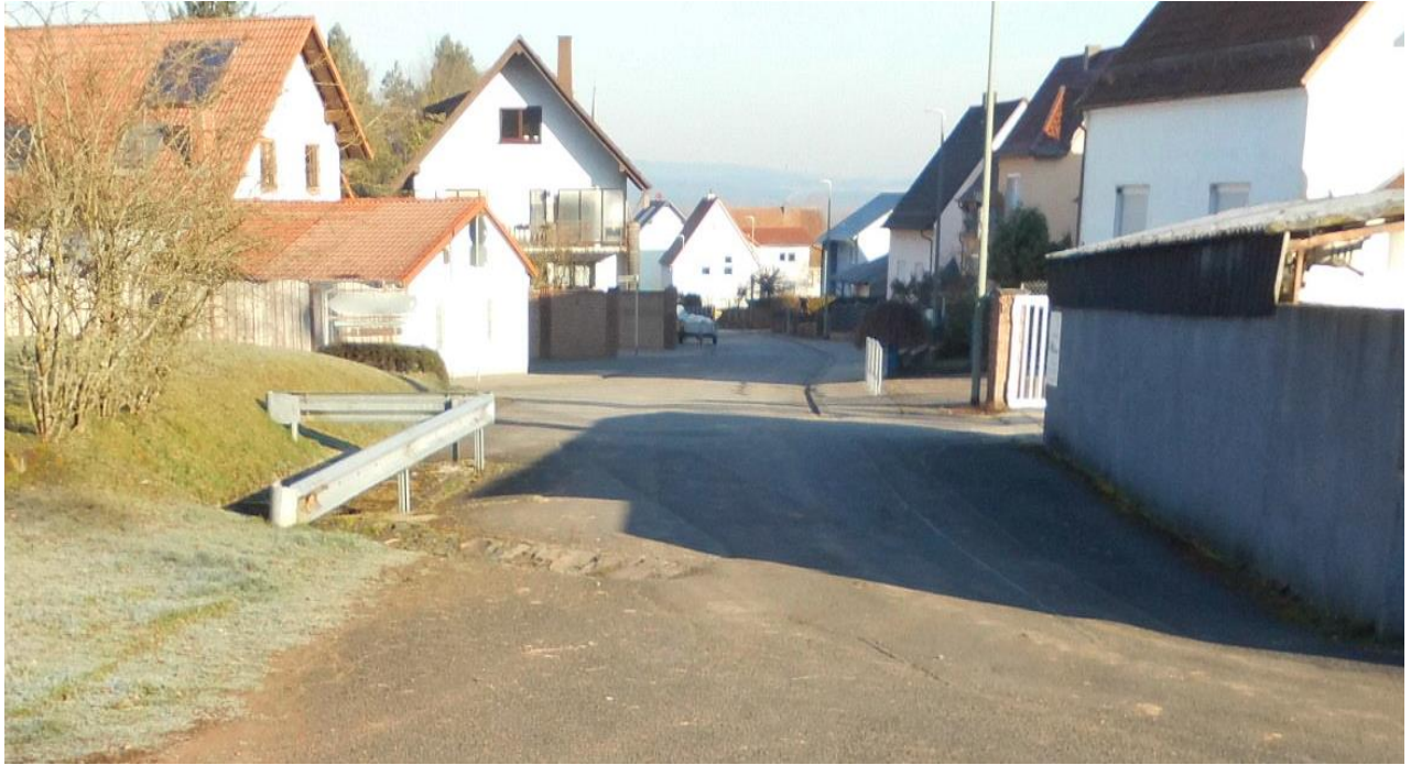
Abbildung: Einlaufbauwerk mit Querrinne „Geisenbergstraße“
