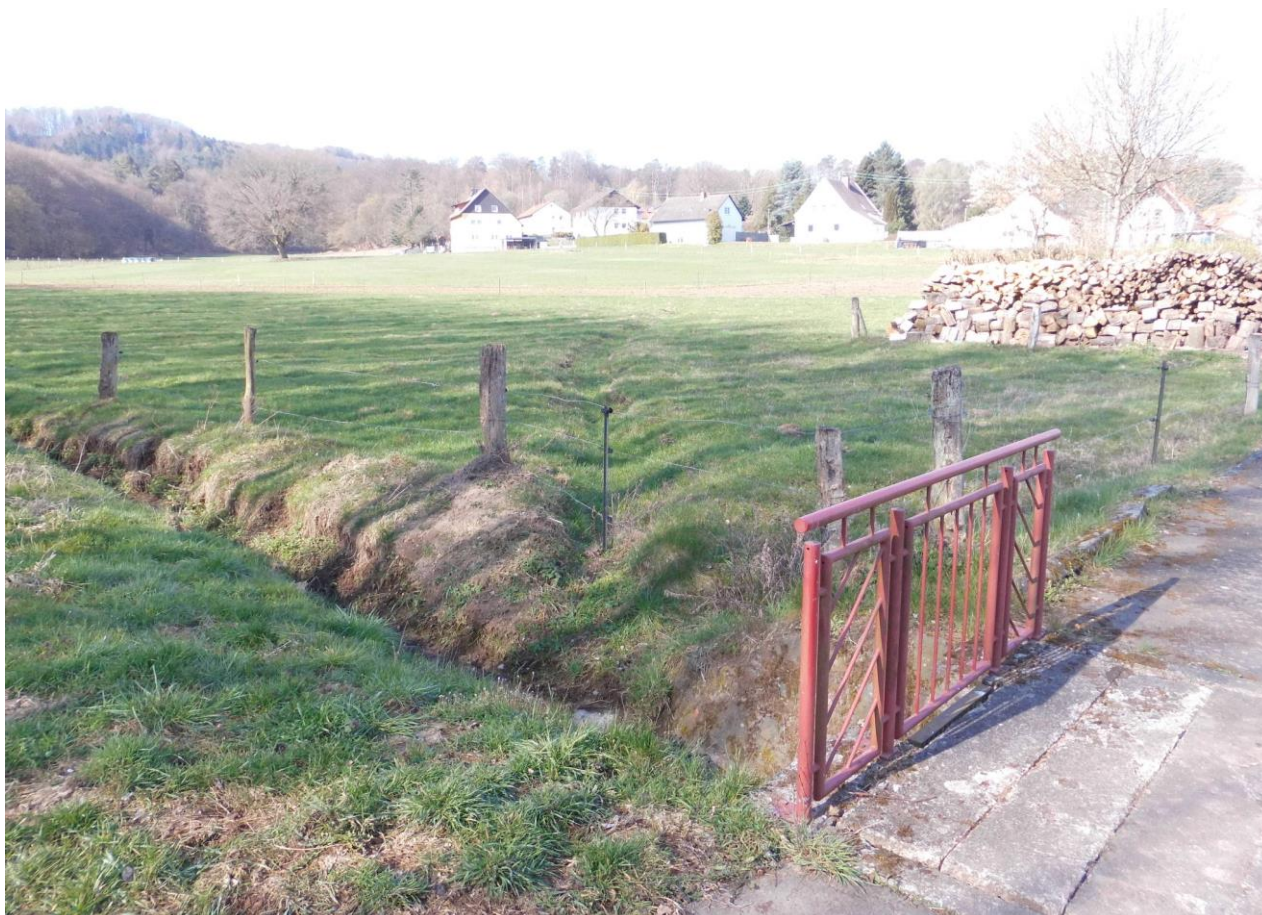
Abbildung: Einlaufbauwerk mit Absturzsicherung
