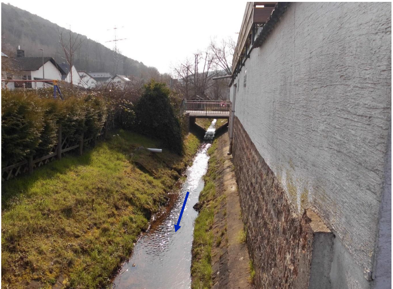
Abbildung: Mühlbach, Blick gegen Fließrichtung zur Brücke der Kaiserstraße
