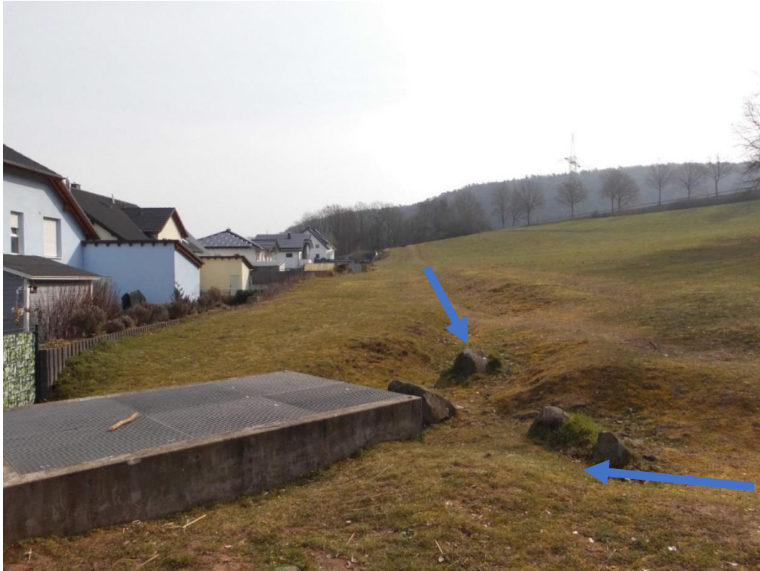
Abbildung: Einlaufbauwerk des Baugebietes „Tannenfeld“ mit Graben
