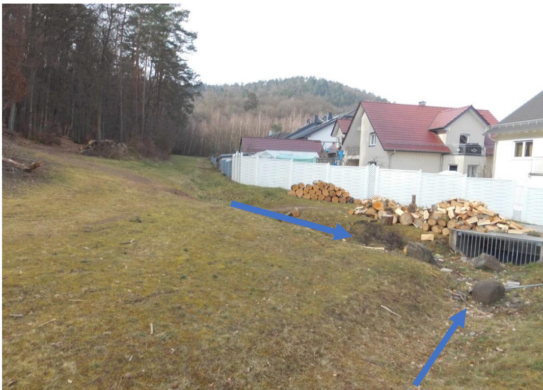
Abbildung: Einlaufbauwerk des Baugebietes „Wolfsdell“ mit Graben
