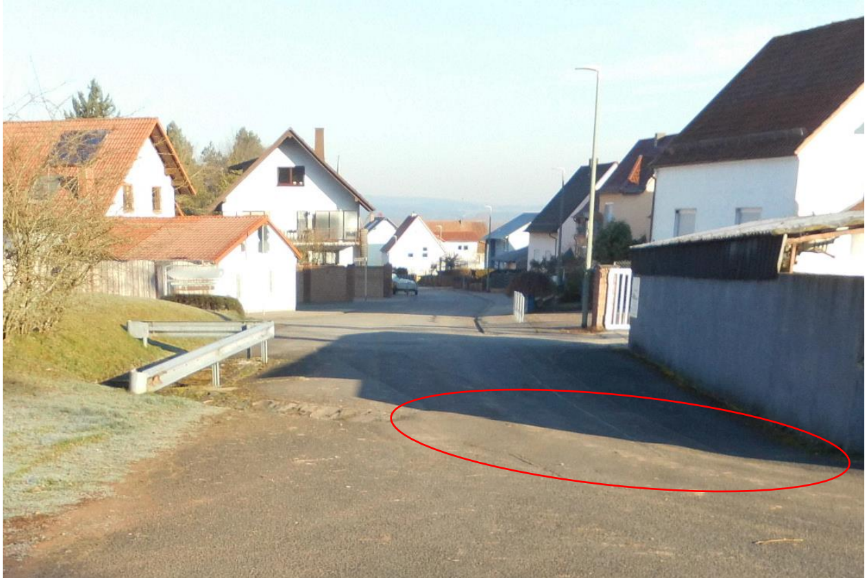
Abbildung: Einlaufbauwerk Geisenbergstraße mit Querrinne
