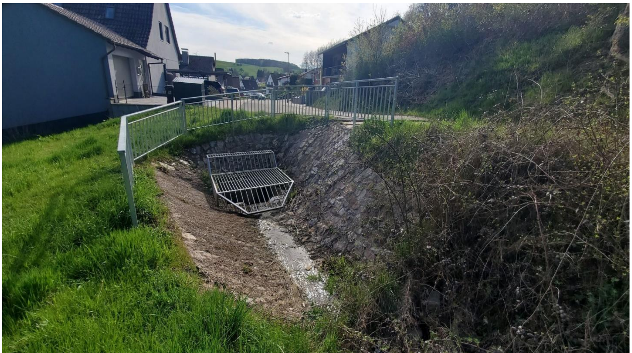
Abbildung: Beispiel für einen überströmbaren Rechen
