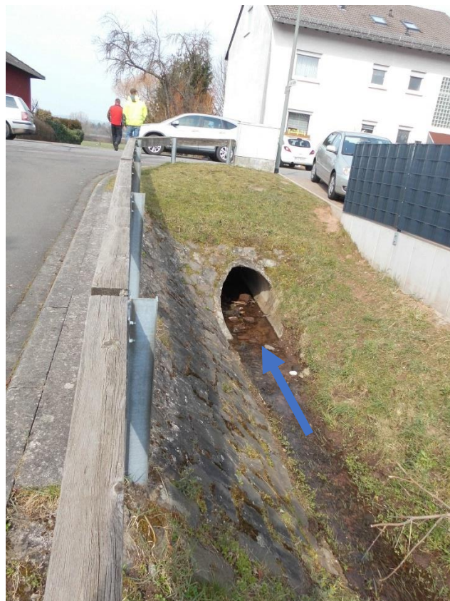
Abbildung: Blick auf die Einlaufsituation der Straßenquerung „In den Betzen“
