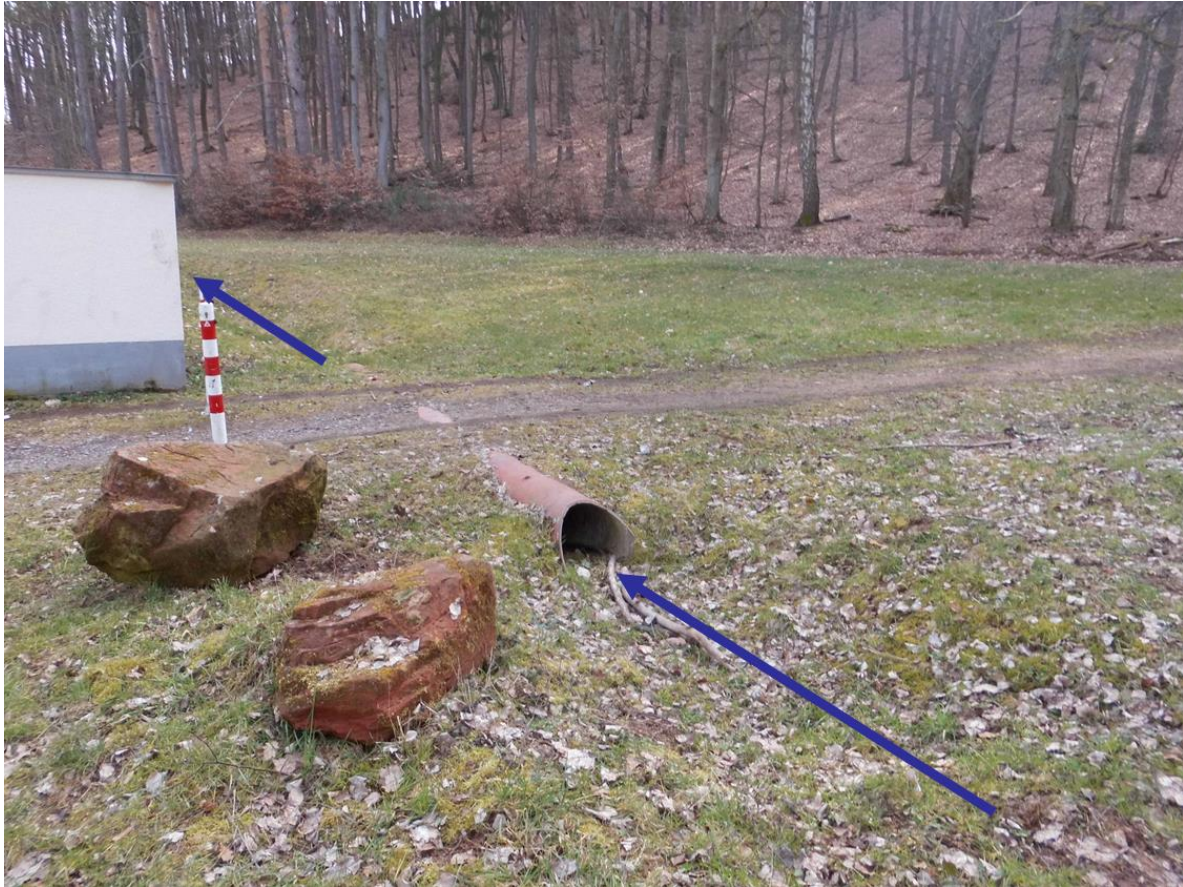
Abbildung: Durchlass oberhalb Wolfsdell
