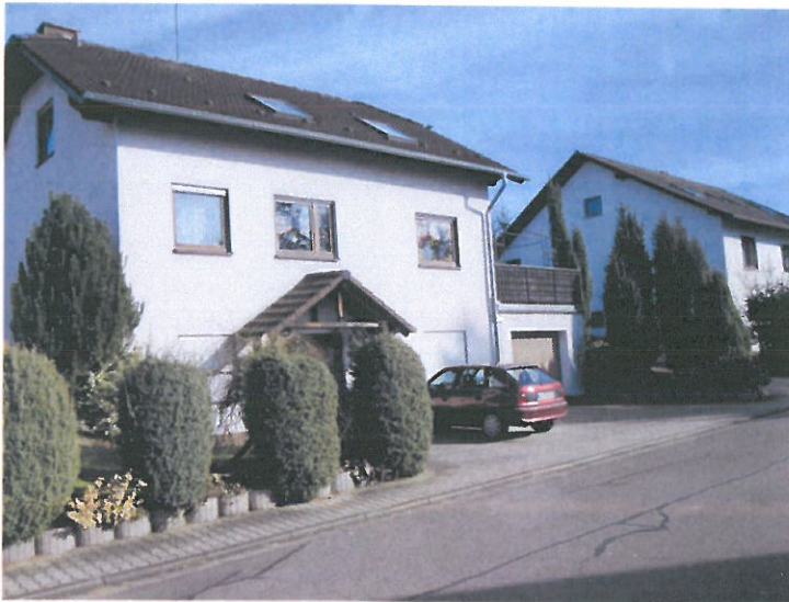
Abbildung 5: Bebauung entlang der Wiesenstraße
