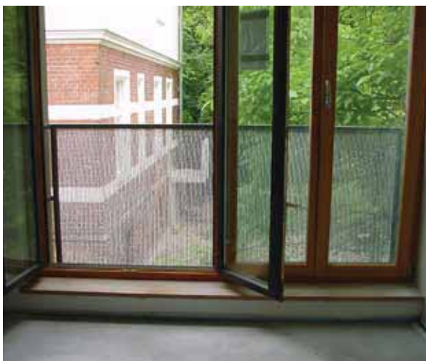
50 Brüstungen aus Metallgewebe sind nicht völlig transparent, bieten aber bei bodentiefen Fenstern Schutz und Ausblick.
