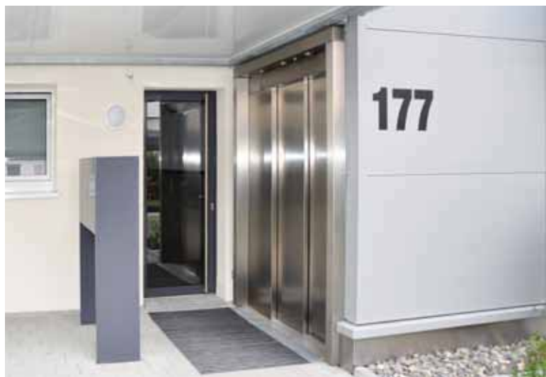
26 Barrierefreie Eingangssituation mit Klingel-/Briefkastenanlage und Aufzug (Mehrfamilienhaus)
