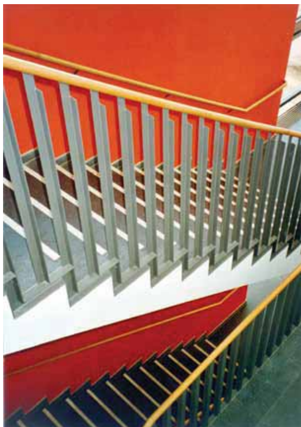
34 Kontrastreich gestaltetes Treppenhaus mit Stufenmarkierungen
