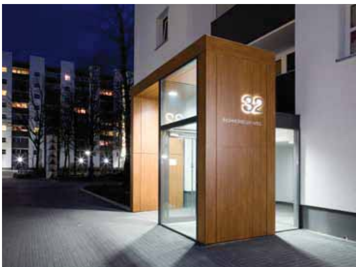
23 Markante und gut beleuchtete Eingänge erleichtern die Auffindbarkeit.
