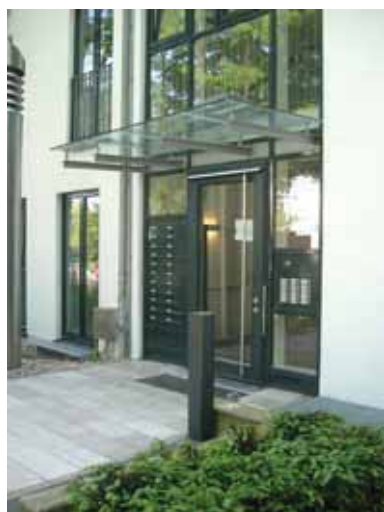
20 – 22 Überdachter Eingangsbereich mit tiefliegenden Briefkästen, zugänglich von innen und außen
