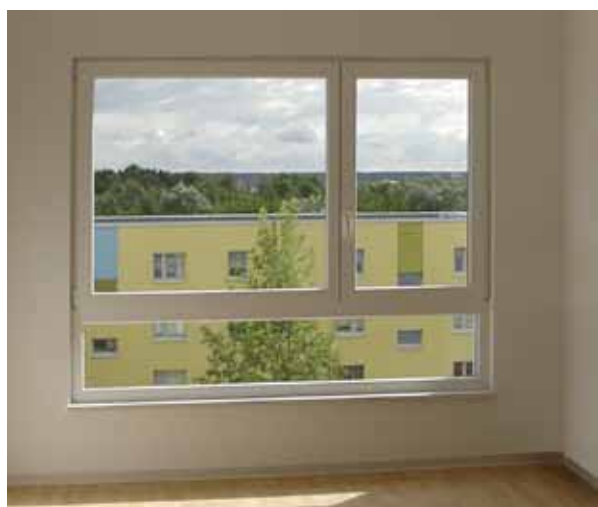
51 Viel Ausblick bei gleichzeitiger Absturzsicherung bieten fest stehende Glaselemente.
