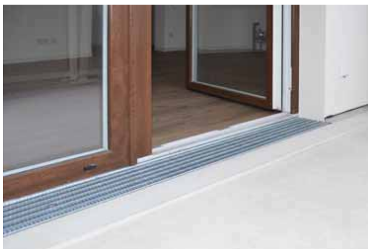
93 Schwellenloser Übergang vom Wohnraum zum Freisitz
