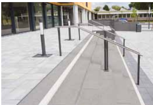
38 Mehrere Handläufe bieten bei breiten Treppenanlagen mehr Sicherheit.
