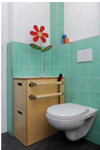
76–78 Individuelle Einbauten für ein rollstuhlgerechtes Bad
