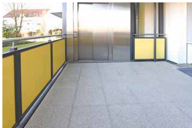
94 Schwellenloser Übergang zum Freisitz von einem angebauten Aufzug
