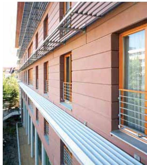
49 Metallgeländer als Absturzsicherung
