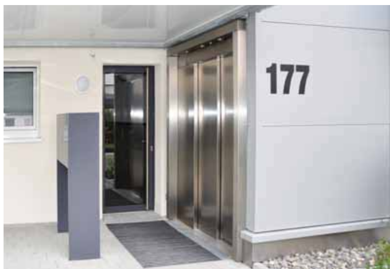
26 Barrierefreie Eingangssituation mit Klingel-/Briefkastenanlage und Aufzug (Mehrfamilienhaus)
